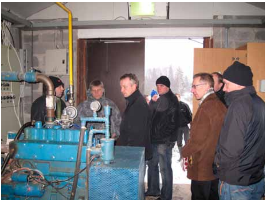
Kuva 8. Bioenergiatutustumiskäynti Kalmarin tilalla (Metener Oy).
