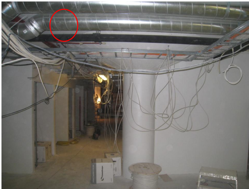
Kuva 27. Yläkellari, tukiasema 1, katto
