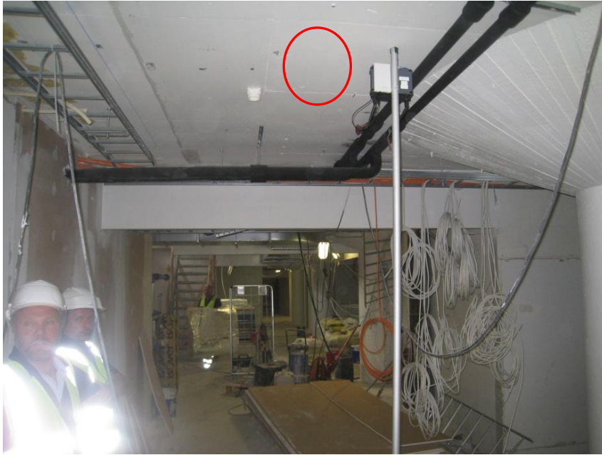
Kuva 29. Yläkellari, tukiasema 2, seinä (asennusseinä ei näy kuvassa)
