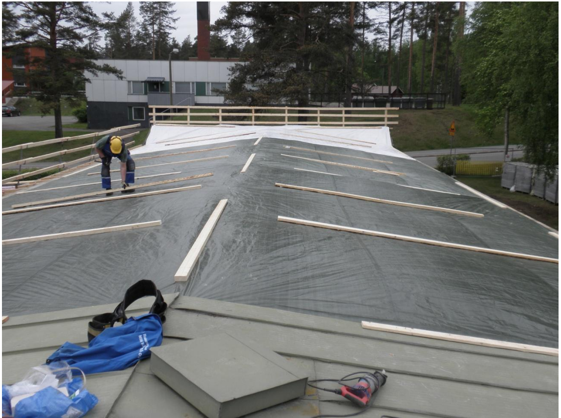
Kuva 7 Vesikaton suojaus (Heikki Hannikainen)
