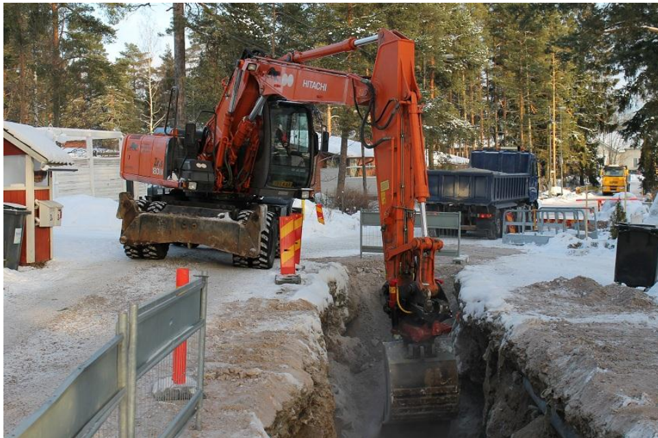
Kuva 2. Rakentaminen tapahtuu useimmiten jo rakennetussa ympäristössä. Putkilinjan kaivamista Rautiaisentiellä tammikuussa 2013. Kuva: Pasi Heiskanen
