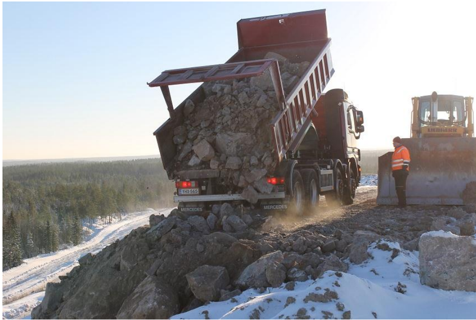
Kuva 4. Katuleikkausten maamassat viedään Espoossa Kulmakorven maanläjitysalueelle. Kuva Pasi Heiskanen
