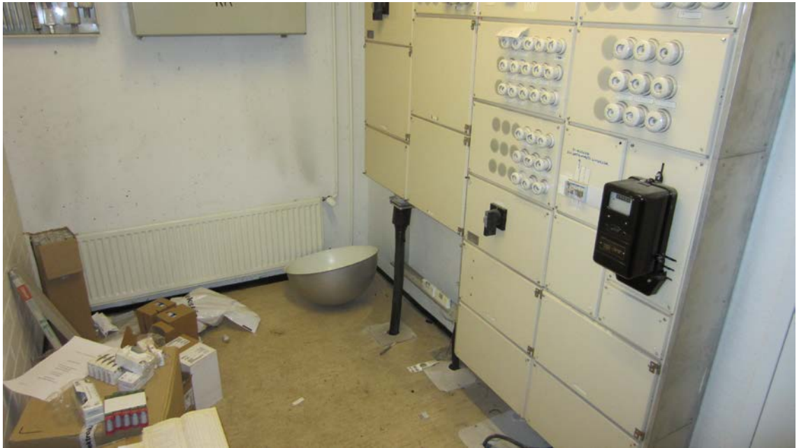
Kuva 4. Sähkökeskuksen lattialla oli paljon ylimääräistä tavaraa.
