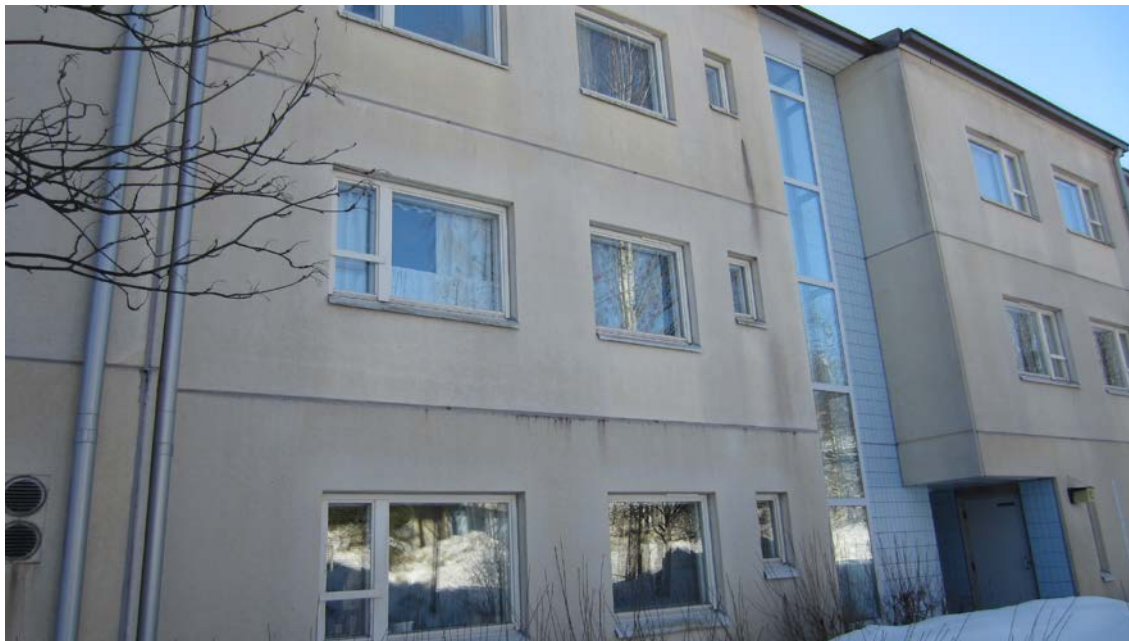
Kuva 1. Tummat alueet julkisivussa ovat punasammalta.
