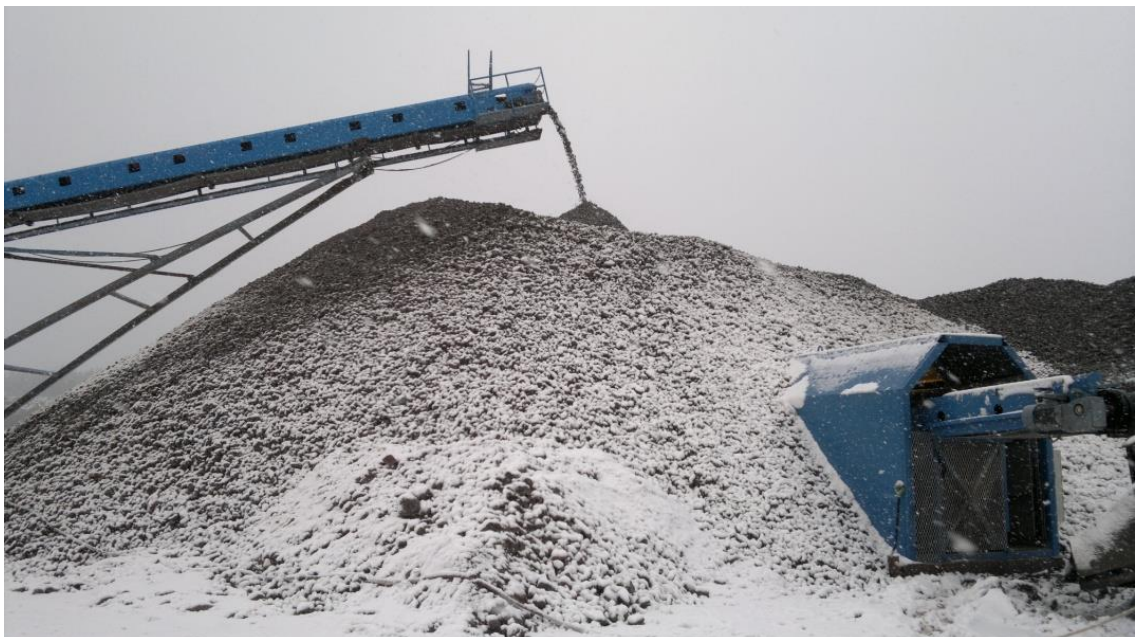
Kuva 8. Seulalta 132 tuleva kiviaines varastoidaan välivarastoon. Kuvassa on myös syöttötunneli.[10]
