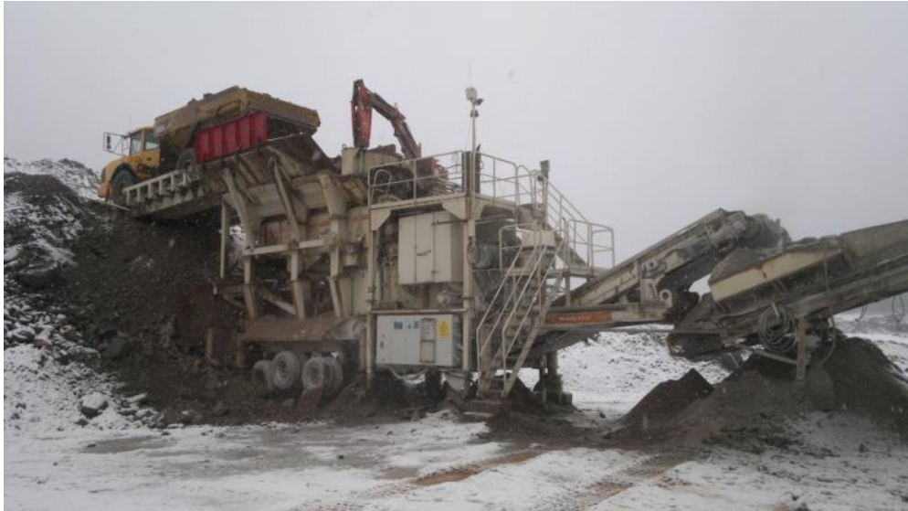
Kuva 4. Dumperi kuljettaa louhetta syöttimelle, joka on liitettyä etumurskaimeen.[10]
