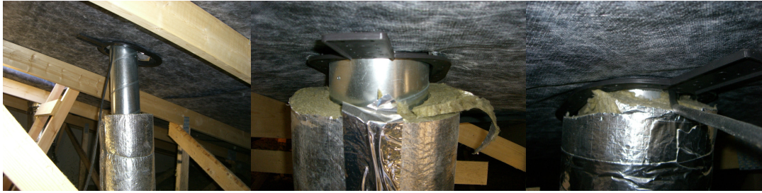
Kuva 11. Puutteellisia kanavaeristyksiä. [11.]
