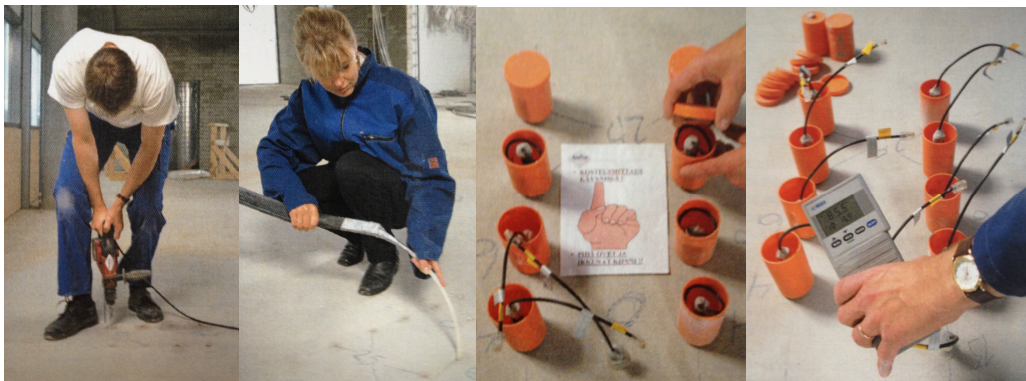
Kuva 15. Betonin suhteellisen kosteuspitoisuuden mittaamisen työvaiheet. [17, s. 13-15.]
