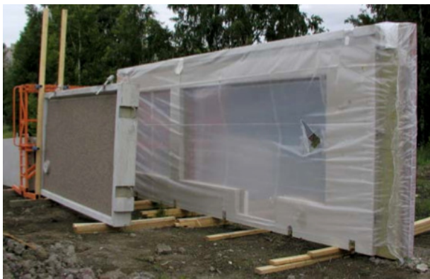
Kuva 17. Elementtien suojaus välivarastoinnin aikana. [21.]
