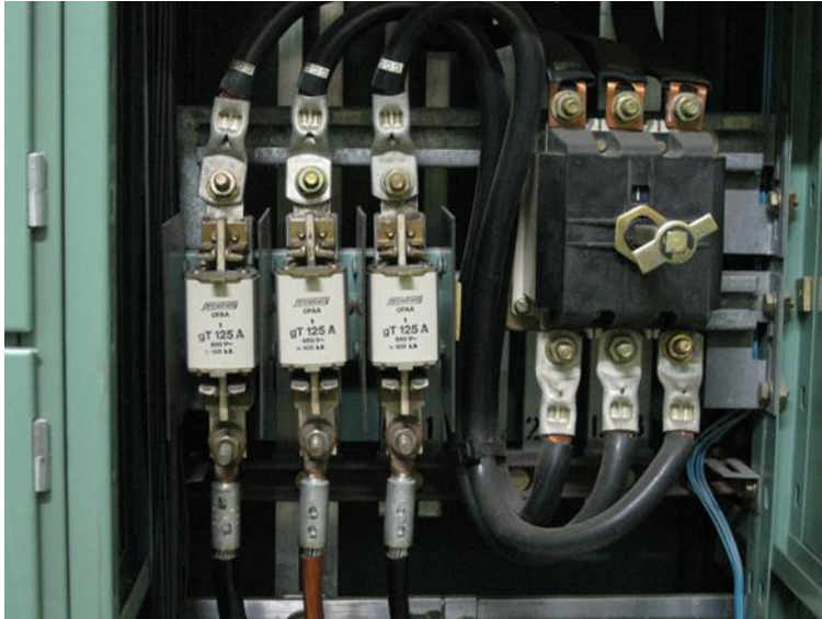
Kuva 8. Keskukselta 1DV syöttö keskukselle 1FA; kuvassa kahvasulakkeet sekä pääkytkin
