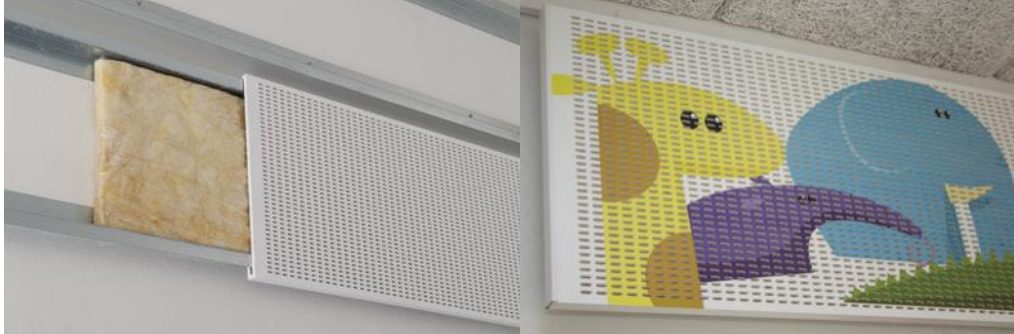
Kuva 5: Vasemmalla: reikälevyn taakse asennetaan huopaa. Oikealla: reikälevyä saa myös erilaisin painatuksin. [15.]
