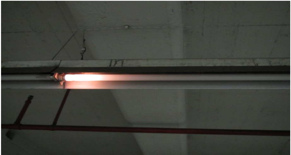
Kuva 5. Loppuun palanut loistelamppu, jonka elektrodit ovat jääneet hehkumaan.
