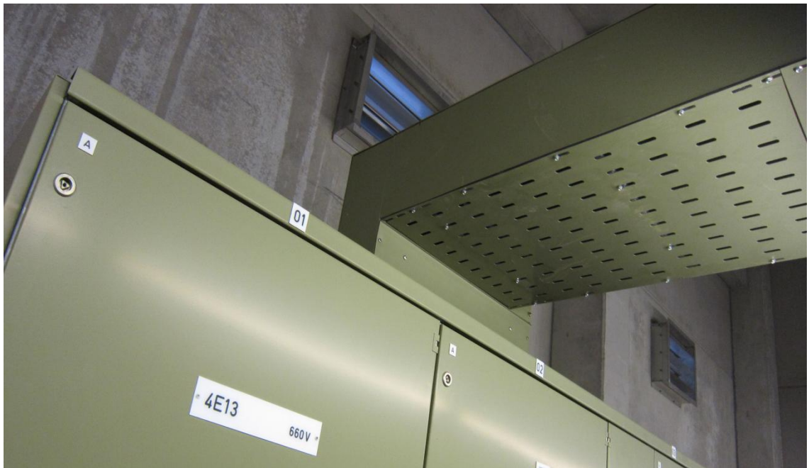
KUVA 10. Keskuksien yläpuolella kulkeva kiskosilta
