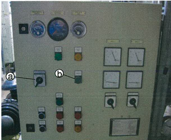
KUVIO 10. Dieselmoottorin käyttöpaneeli. a) Käyttötapakytkin b) Käynnistyskytkin
