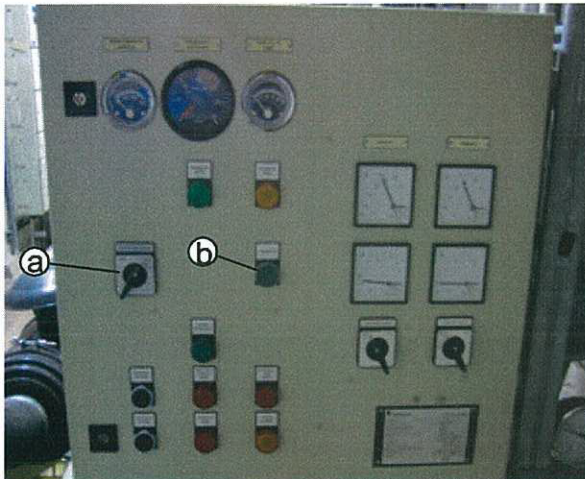
KUVIO 10. Dieselmoottorin käyttöpaneeli. a) Käyttötapakytkin b) Käynnistyskytkin
