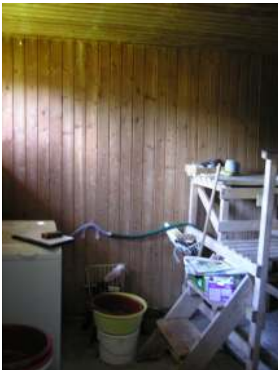
Kuva 25 Saunan ja pesuhuoneen taka-seinä suoraan ovealta katsottuna.
