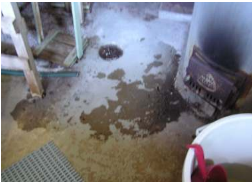
Kuva 27 Tilan ainoa lattiakaivo, sekä maalattu betonilattia /Mariana Ravonius/
