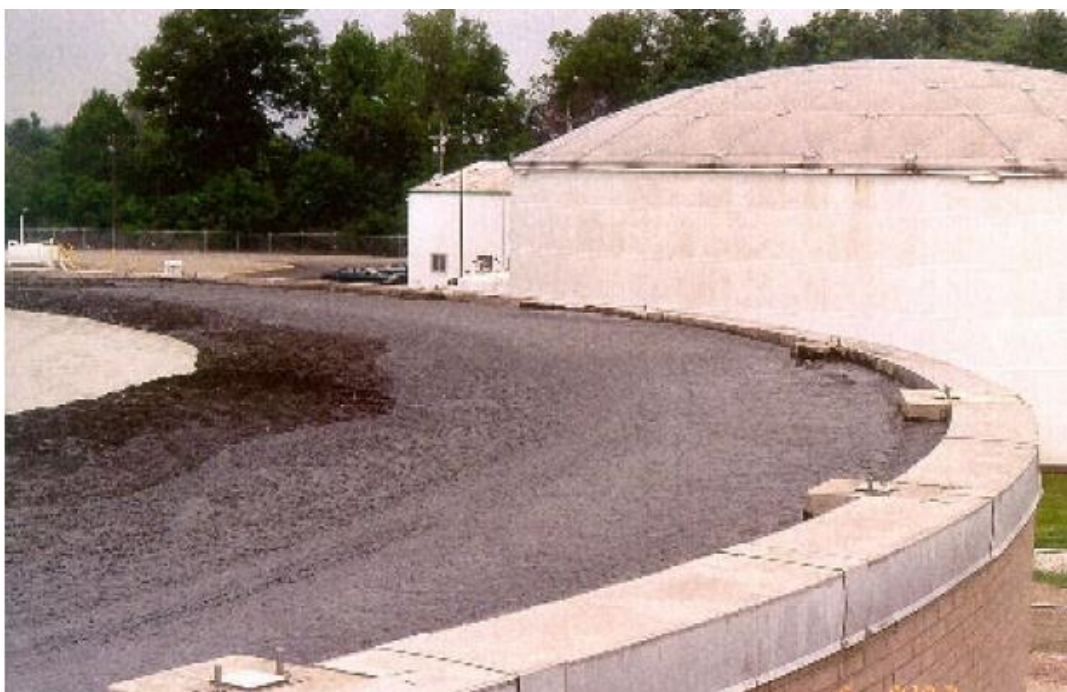
Figur 4. Kraftig skumning vid anläggning i USA. Skummet (mörkbrunt) har svämmat över upp på taket (beigt). Hela taket täcks av skum, förutom mitten, som man håller på och spolar rent med vatten (figur 5) (Bates m.fl. 2006, s. 2).
