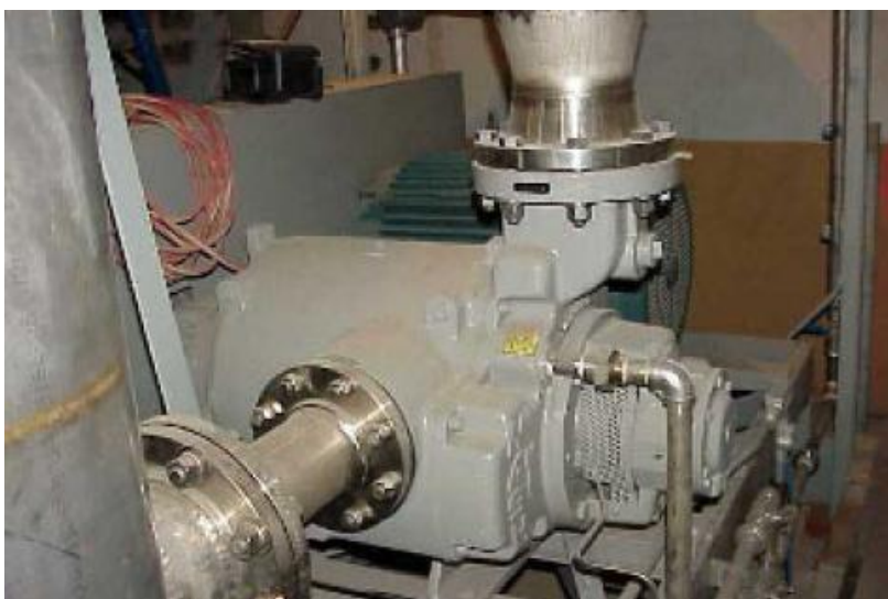
Figur 12. Biogaskompressor för omblandning (Bates m.fl. 2006, s. 21).
