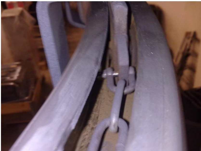
Kuva 18. Kiinnityskettinki palkin sisällä.
