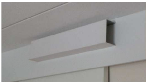
Kuva 13. Tuloilmapäätelaitteen päälle asennettu peltikotelo.
