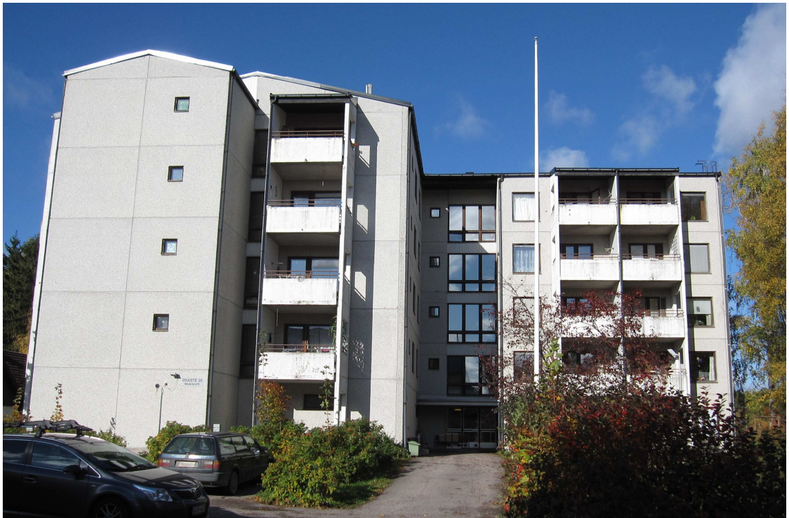
Kuva 2. Rakennuksen julkisivu, Osuustie Mäntsälä
