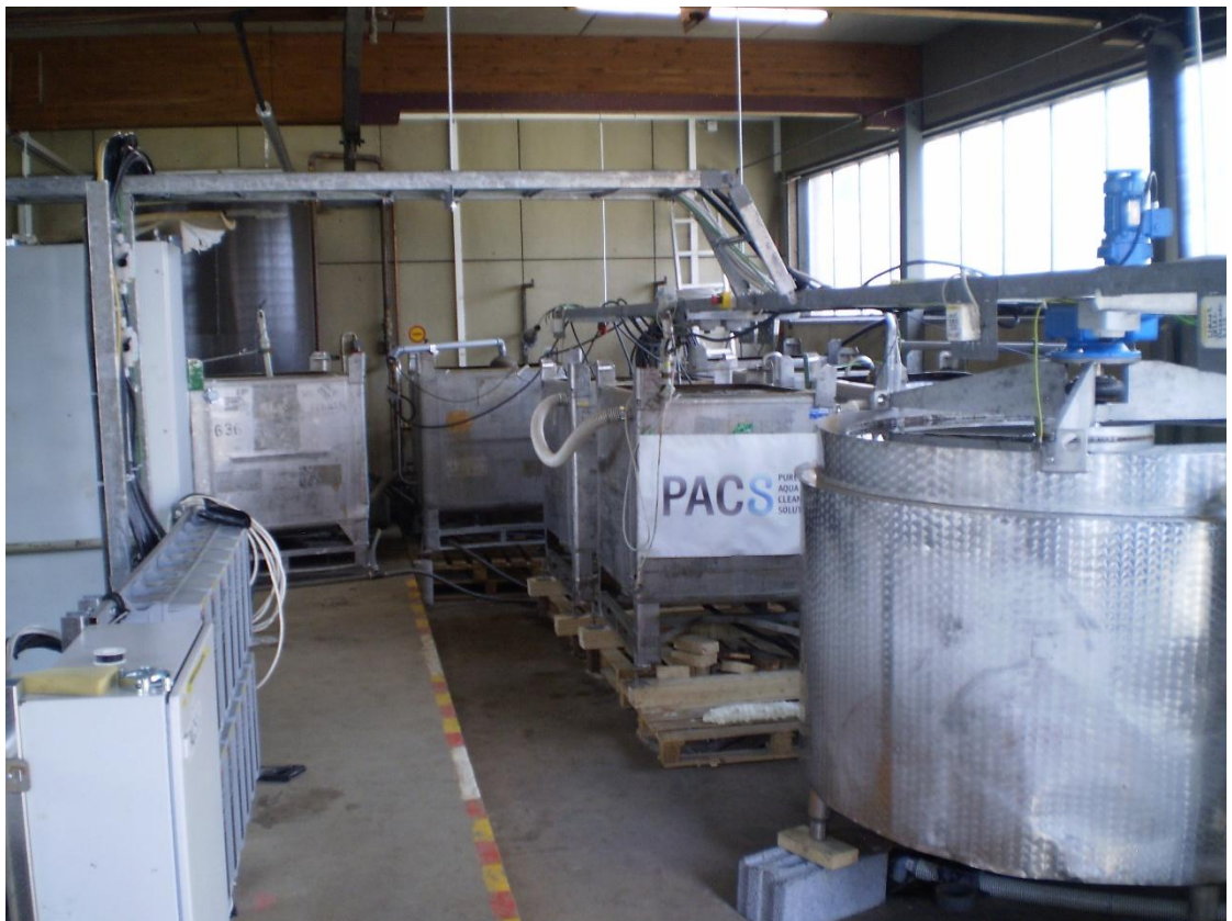
KUVA 19. Toimintakunnossa oleva pilot-laitos. (Mämmelä 2013.)
