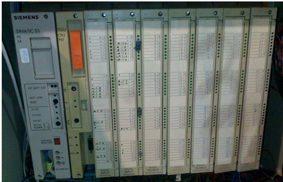
Kuva 14. Sokkelikoneen Simatic S5-115U logiikka
