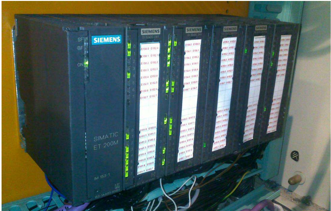
Kuva 16. Asetinrengaskoneen uusi ET200-kortti sekä hajautetut IO-kortit
