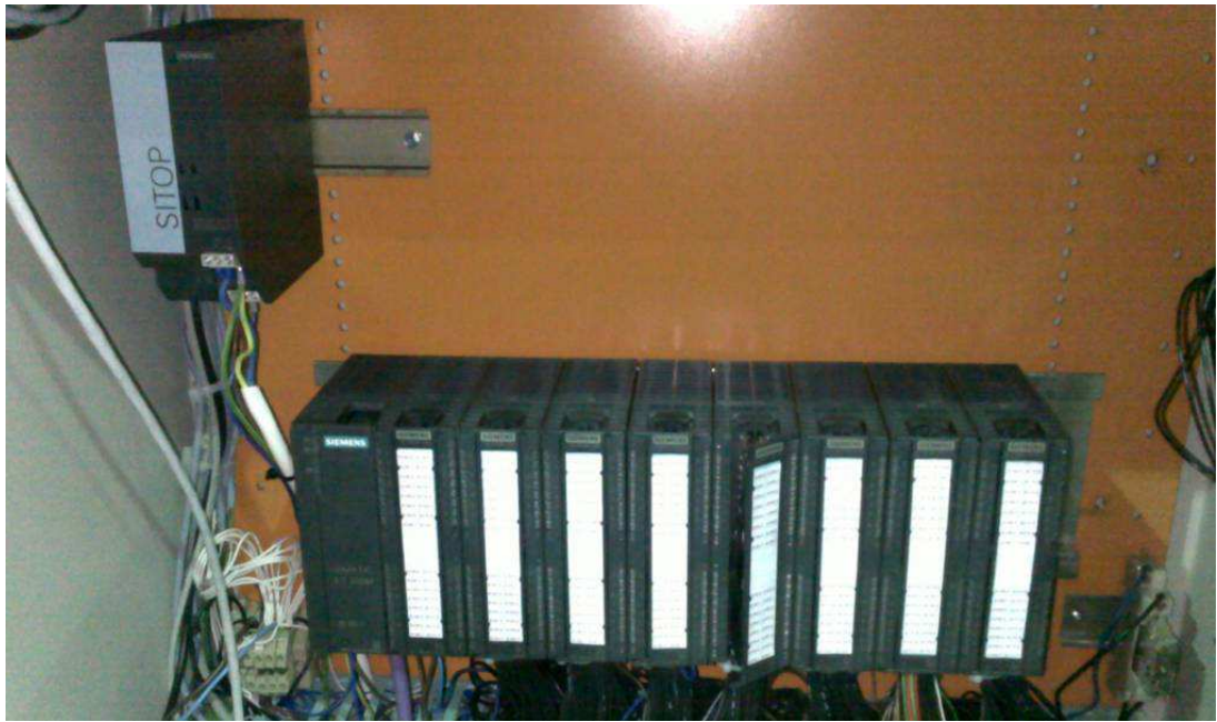
Kuva 17. Sokkelikoneen uusi ET200-kortti sekä hajautetut IO-kortit
