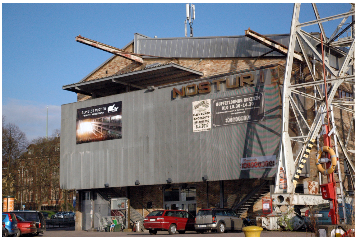
Kuva 1. Nosturin julkisivu ja sisäänkäynti (Kuva: Aki Rahkonen)
