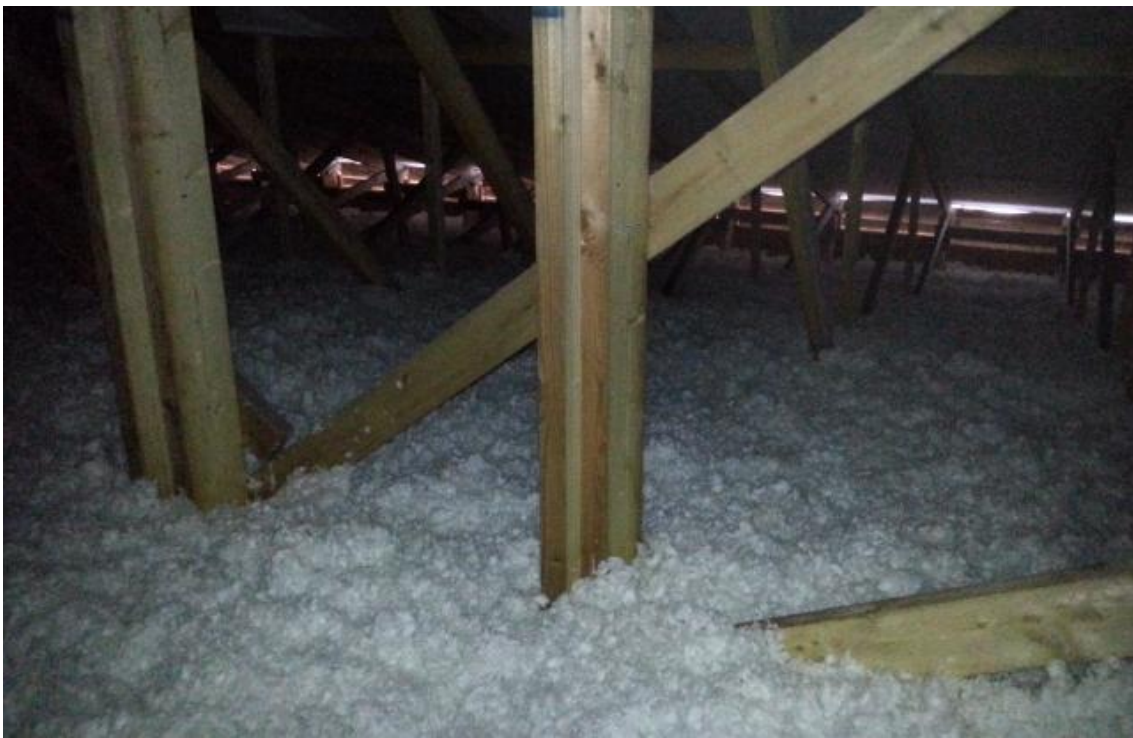
KUVA 14. Emolehmäkasvattamon yläpohjaa, jossa tuuletus räystäältä
