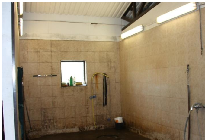
Kuva 22. Pesupaikan valaistus (Vattinen 2013)
