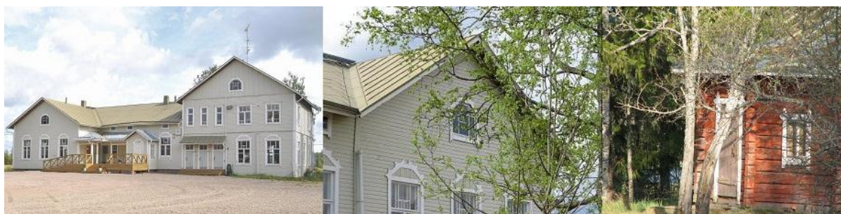
Kuva 7: Joenvarren Seurahuone (Joenvarren Seurahuone 2012a)
