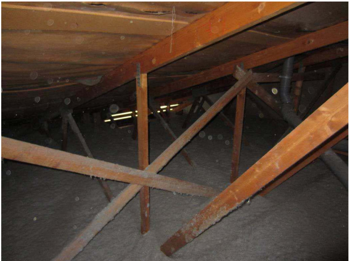
Kuva 4. Lisälämmöneristetty yläpohja hyvin tuulettuvalla alaräystäällä [2].
