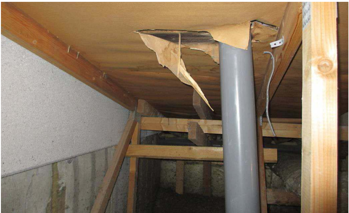
Kuva 15. Eristämätön tuuletusputki [2].
