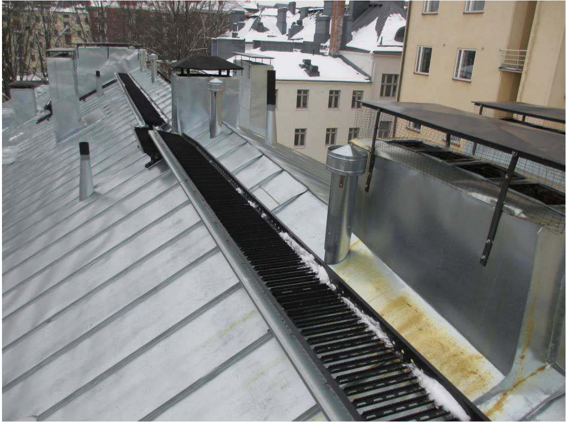
Kuva 2. Yleiskuvaa jyrkästä rivipeltikatosta [2].
