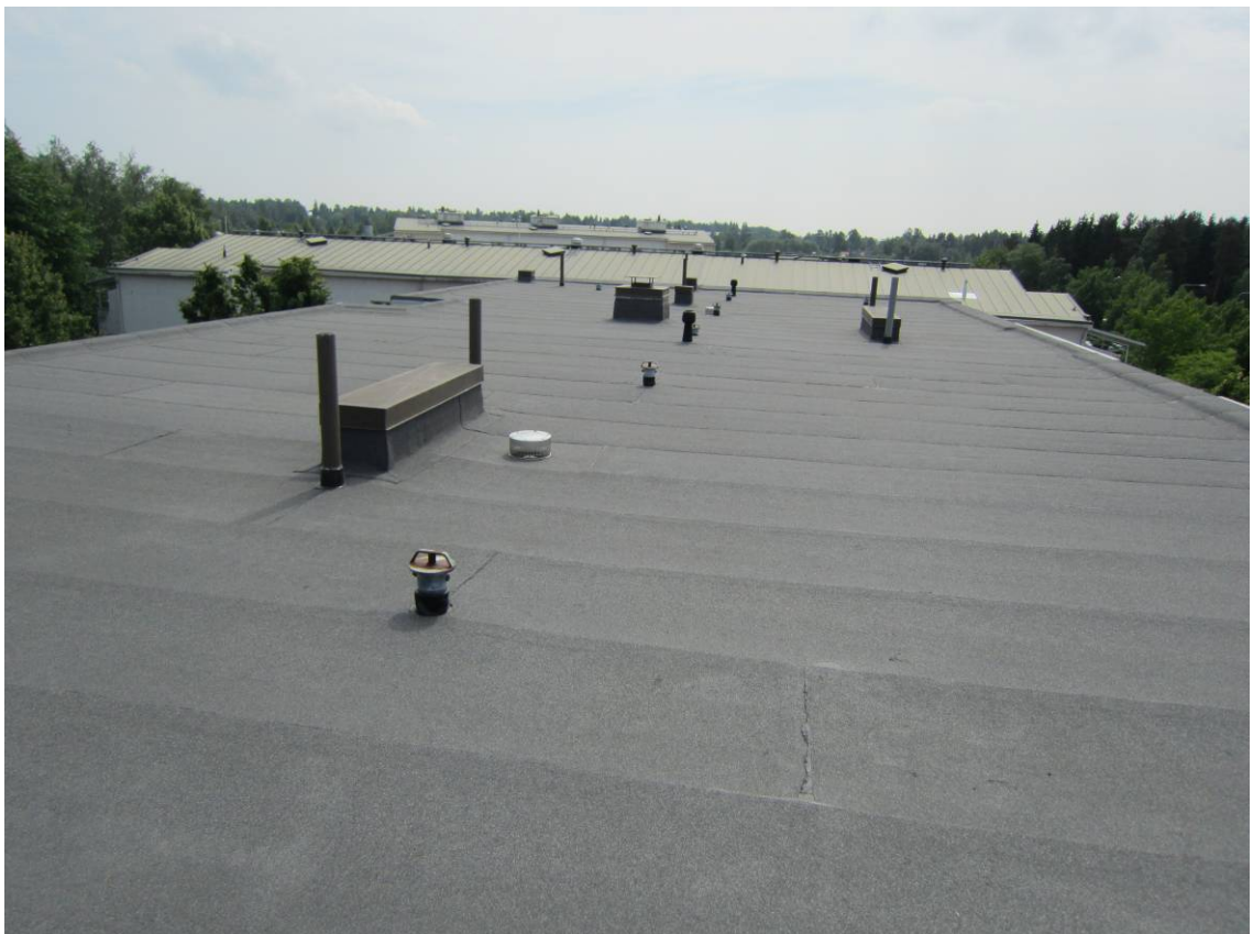
Kuva 1. Yleiskuvaa loivalta katolta [2].
