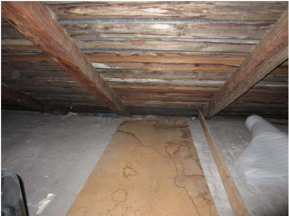
Kuva 12. Heikosti tuulettuva alaräystä [2].
