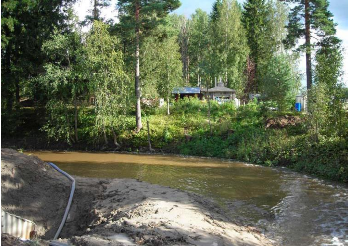
Kuva 7. Työpato ja sen kuivana pito. [1]
