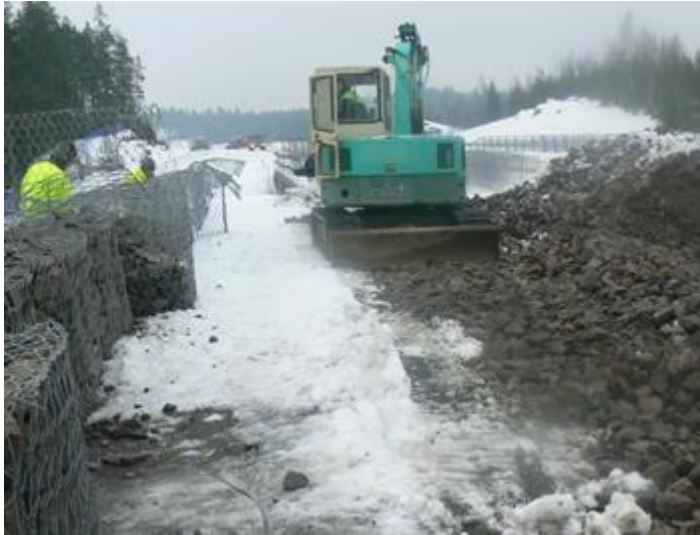
Kuva 5. Vanhaan työtapaan tehtävät kiviakorit. [1]
