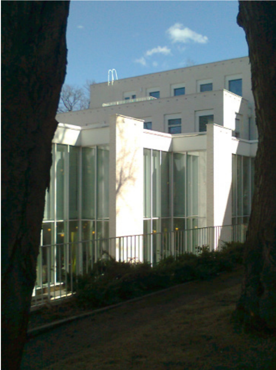
Bild 41. Universitätsgebäude der Helsinki Universität. (Paajanen 2013.)
