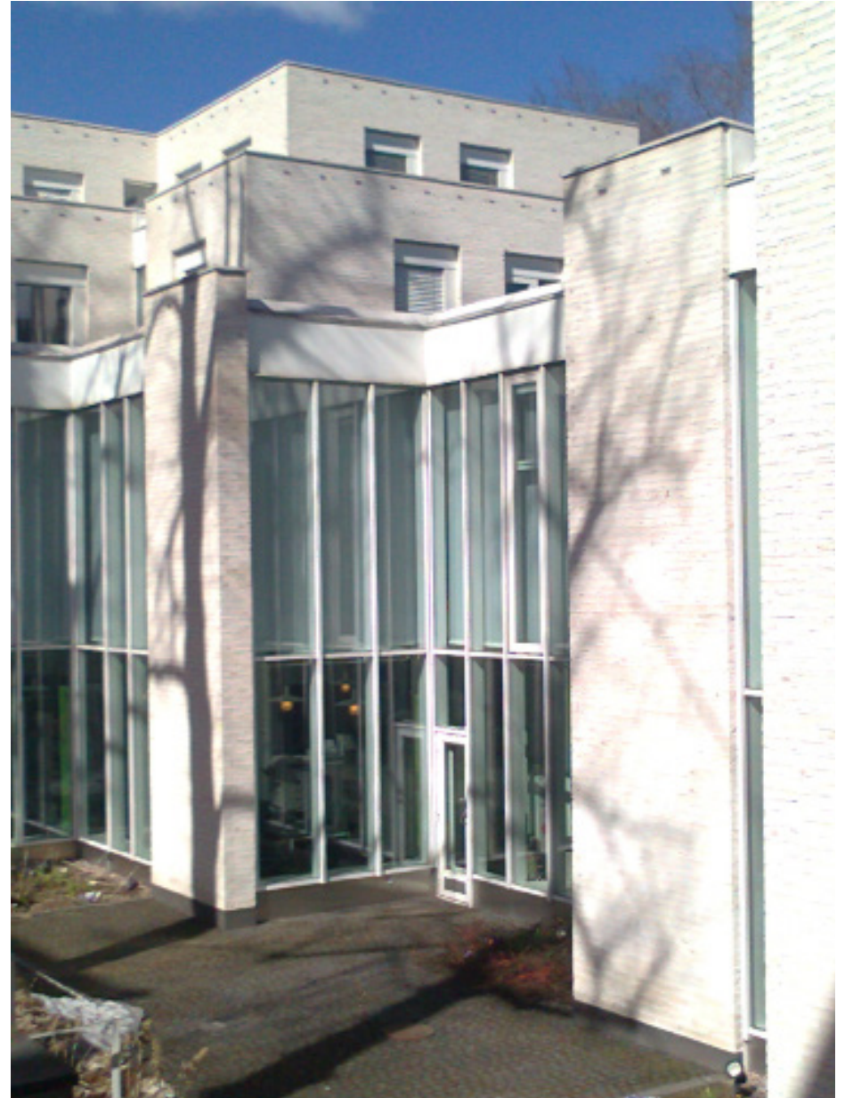
Bild 42. Universitätsgebäude der Helsinki Universität. (Paajanen 2013.)
