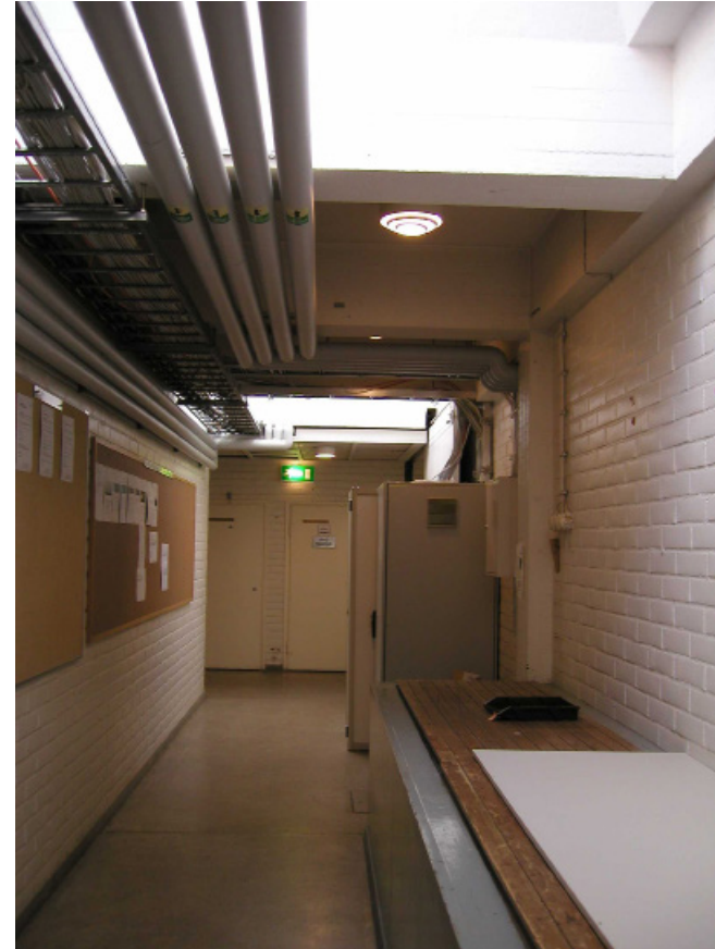
Bild 14. Ein Flur mit Dachfenster und Tageslicht in einem Laborgebäude der Technischen Hochschule Helsinki / heute Aalto-Universität. (Paajanen 2005.)
