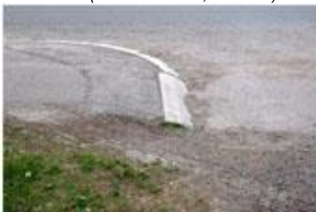
KUVA 40. Korkea reunakivi sekä kadun reunassa että keskisaarekkeena toimivassa liikenteenjakaajassa. Suojatie on tehty paikalle syntyneen oikopolun virallistamiseksi (Ahlströminkatu, Varkaus)
