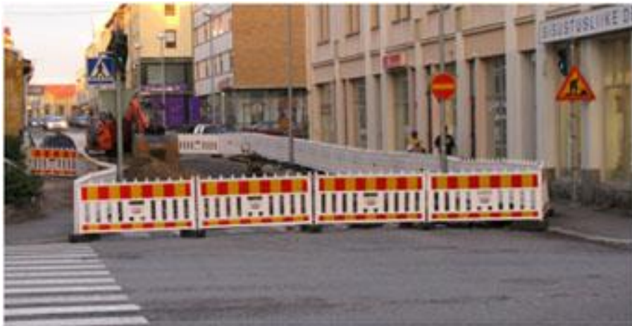
KUVA 33. Katutöiden ajaksi työmaa-alue tulee suojata aidoin, jotka pystyy havaitsemaan myös näkövammaisen valkealla kepillä. (Asemakatu, Oulu)
