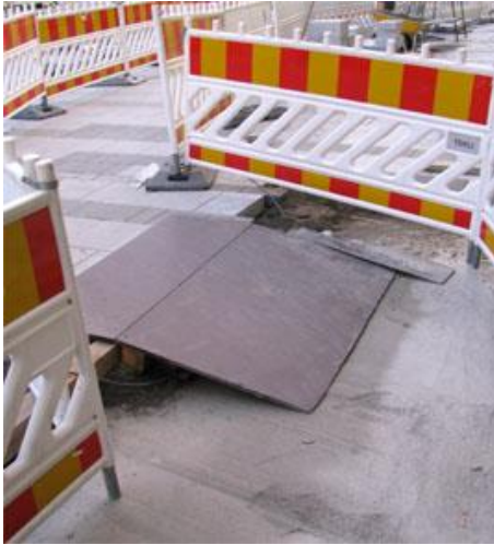
KUVA 34. Tilapäistä esteettömyyttä työmaalla (Kauppurienkatu, Oulu)
