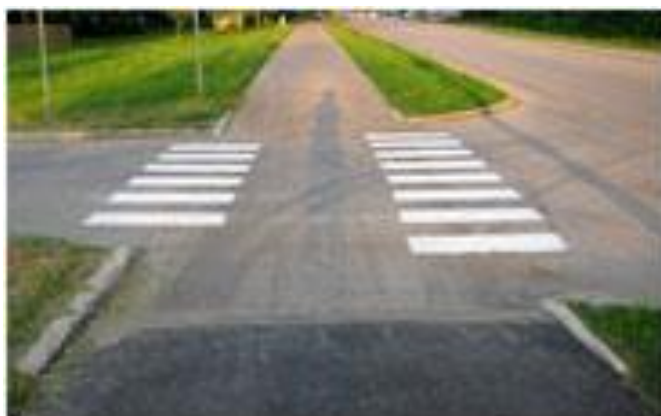
KUVA 55. Aiemmin yhdistetyillä jalankulku- ja pyöräteillä ei reunakiviä juuri käytetty, vaan luiska tehtiin asfaltilla ( Leppäkuja, Varkaus)
