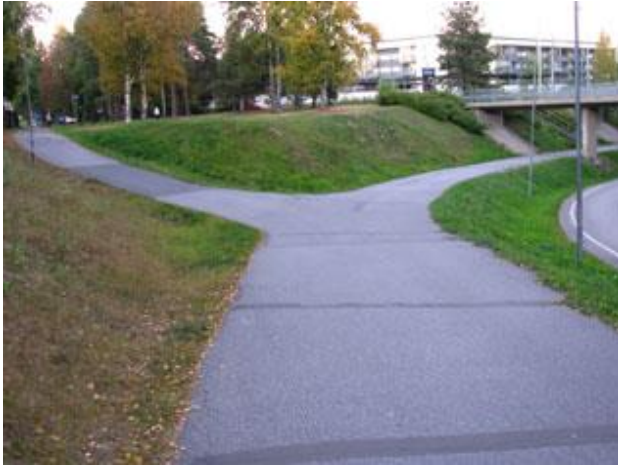
KUVA 15. Alikulkujen vaatimien korkeuden muutosten huomioimiseen tarvitaan runsaasti tilaa myös maastoltaan tasaisessa Oulussa (Kenttätie, Oulu)
