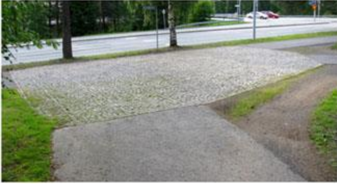
KUVA 21. Neljän yhdistetyn jalankulku- ja pyörätien liittymä on päällystetty karkein noppakivin. Huomiokiveys on kyseisellä paikalla tarpeellinen, mutta syksyaamuisin kiveys saattaa olla vaarallisen liukas yökasteen jäätyessä kivenpintaan viereisen asfaltin ollessa sula (Professorintie, Oulu)
