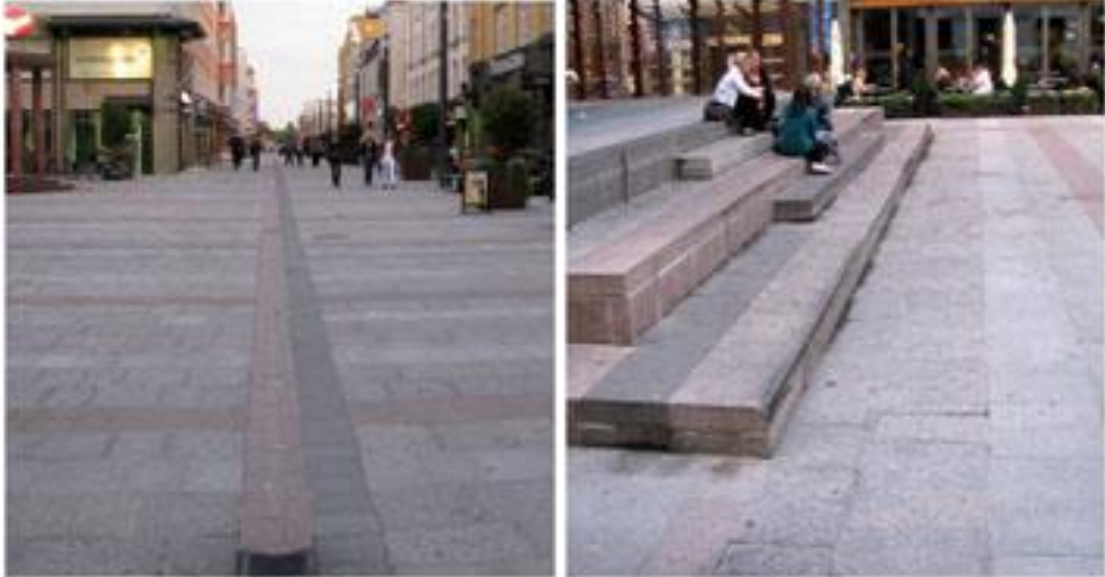
KUVA 9. Tummaraidan kontrasti on liian pieni muuhun katupäällysteeseen nähden. Raidan vieressä punagraniittinen laakea vesikouru on oikeaoppisesti kadun pääsuunnanmukainen (Rotuaarinaukio, Kirkkokatu, Oulu)
