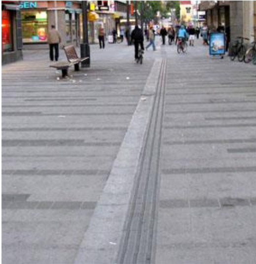
KUVA 11. Kesällä 2013 saneerattua kävelykatu Rotuaaria Kauppurienkadulla. Keskellä vasemmalla laakea vesikouru ja oikealla uritettuja ohjauslaattoja (Kauppurienkatu, Oulu)
