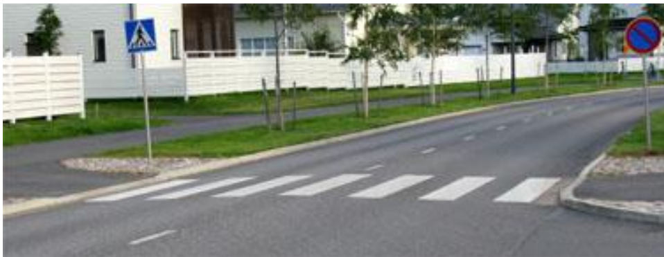
KUVA 54. Nykynormein toteutettu suojiatie. Reunatuet liukuvalettua betonia (Eränkävijäntaival, Aaltokangas, Oulu)
