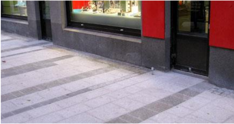
KUVA 8. kadun pinnannostolla on poistettu erillisen porraskiven tarve (Kauppu- rienkatu, Oulu)
