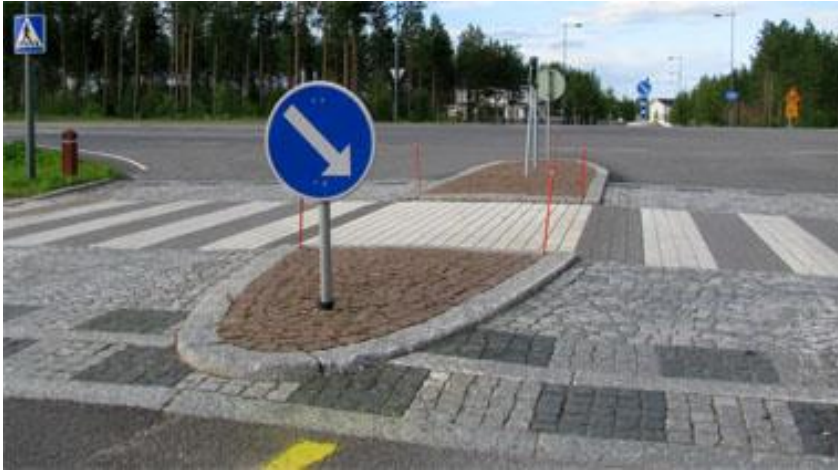
KUVA 53. Kaupunginosia yhdistävä yhdistetty jalankulku- ja pyörätie ylittää Versotien korotetulla suojiatiellä Kuivasrannalla. Keskisaareke on päällystetty valkoisilla betonitiilillä erottumaan muusta suojiatiestä (Versotie, Oulu)
