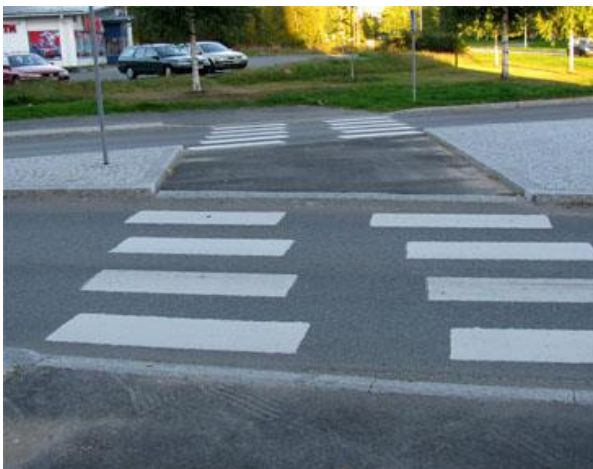
KUVA 49. Nykyisen mallin mukaan kesällä 2012 toteutettu suojatie kiertoliittymässä (Kaarnatie, Oulu)
