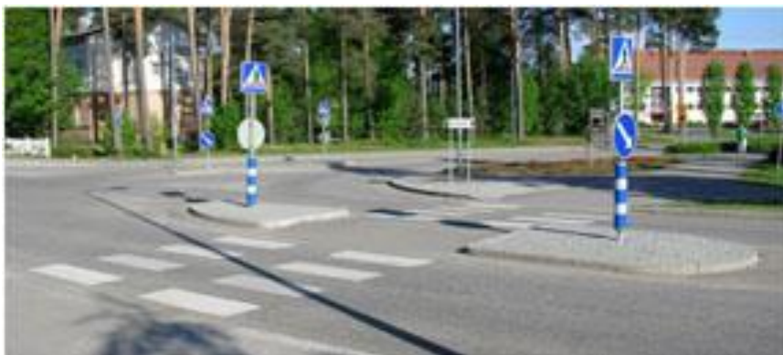
KUVA 52. Yhdistetty jalankulku- ja pyörätie ylittää alueellisen pääkadun Oulussa. Liittymä on kunnostettu 2000-luvun alussa silloisten käytäntöjen mukaan (Kasarmintie, Oulu)
