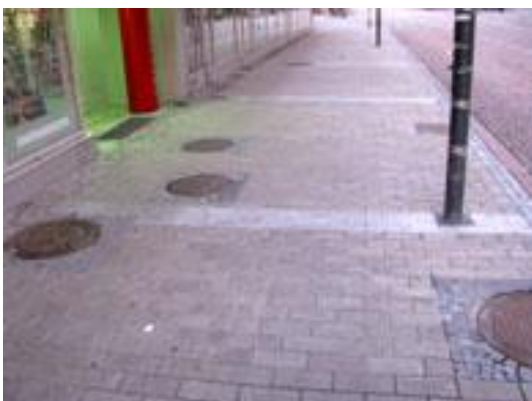
KUVA 22. Laadukaasti toteutettua katupäällystettä. Reunatunnistevyöhykkeet sekä seinän että reunakiven vieressä. Kaivonkannet ja valopylväät ympäröity varoittavalla materiaalilla. Vaaleat poikittaisraidat ovat lähinnä esteettisistä syistä (Saaristonkatu, Oulu)
