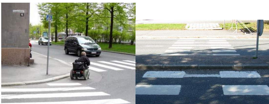
KUVA 39. Korkea reunakivi voi olla todellinen este. Kauppakadun ja Hämeenpuiston liittymä Tampere (Tampereen keskusta-alueen esteettömyyssuunnitelma 2005)
