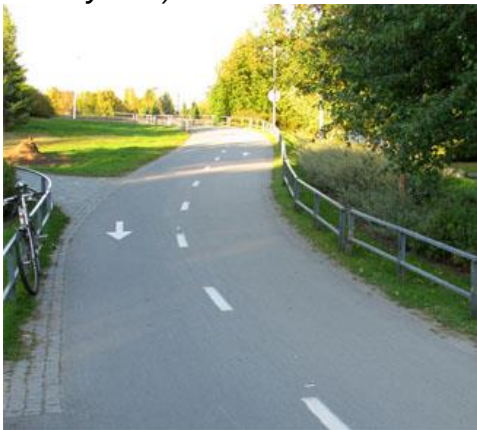
KUVA 28. Kivipylväin eroteltu jalkakäytävä ja pyörätie (Katajanokka, Helsinki; Lari Nylund)
