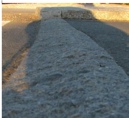
KUVAT 50 ja 51. Oulussa nykyisin käytössä oleva suojatien reunakiven asennusohje ja asennettu kivi lähikuvassa Rajakaltionkadulla Alppilassa
