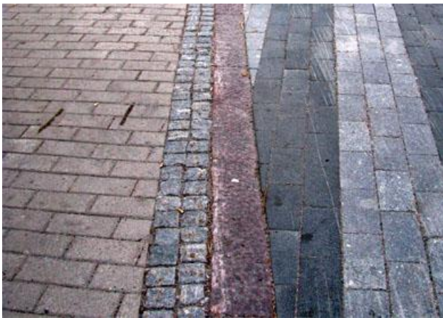
KUVA 61. Noppakivistä tehty varoitusraita reunakiven takana suojaiteille tultaessa. (Torikatu, Oulu)
