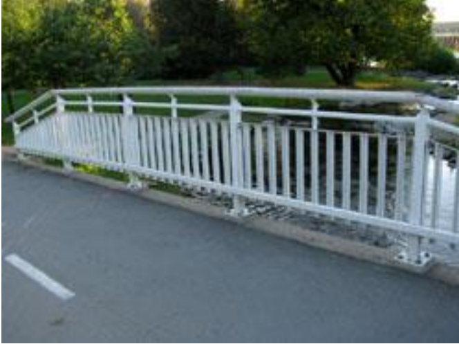
KUVA 18. Suojakaide vesistösilalla (Lassinkallion kalatien silta, Oulu)
