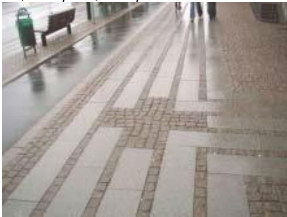
KUVA 23. Pinnoite-erot ohjaavat liikkumista. Sileä väylä ohjaa sekä näkövammaisia että toimii myös tasaisena pyörätuoliväylänä aukion yli. (Frenckellin aukio, Tampere; Tampereen keskustaalueen esteettömyyssuunnitelma 2005)
