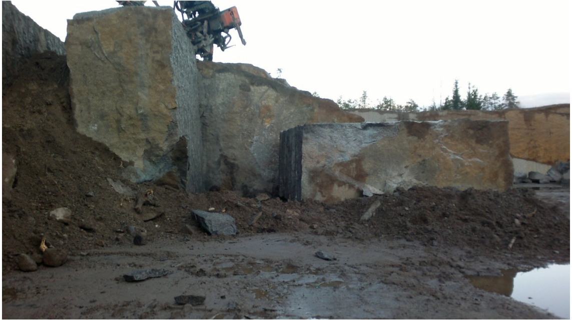
Kuva 18. Kaatolohkareet väliltä 19,5 m-24,2 m ja linjojen 4,1-8 m väliltä. Pystyssä olevan kaatolohkareen alaosassa näkyy räjäytyksessä rikkoutunut osa, jossa näkyvissä on myös mustaa nauhaa. Kamin katkeamakohtissa on tässä kohtaa ruosteisia pintoja, jotka johtuvat pintaveden pääsystä kalliorakoihin.
