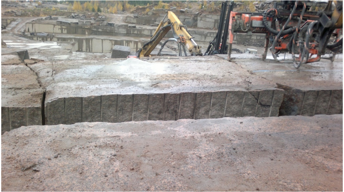
Kuva 16. Väli 19,5 m-24,2 m on ehjän näköistä kiveä.
