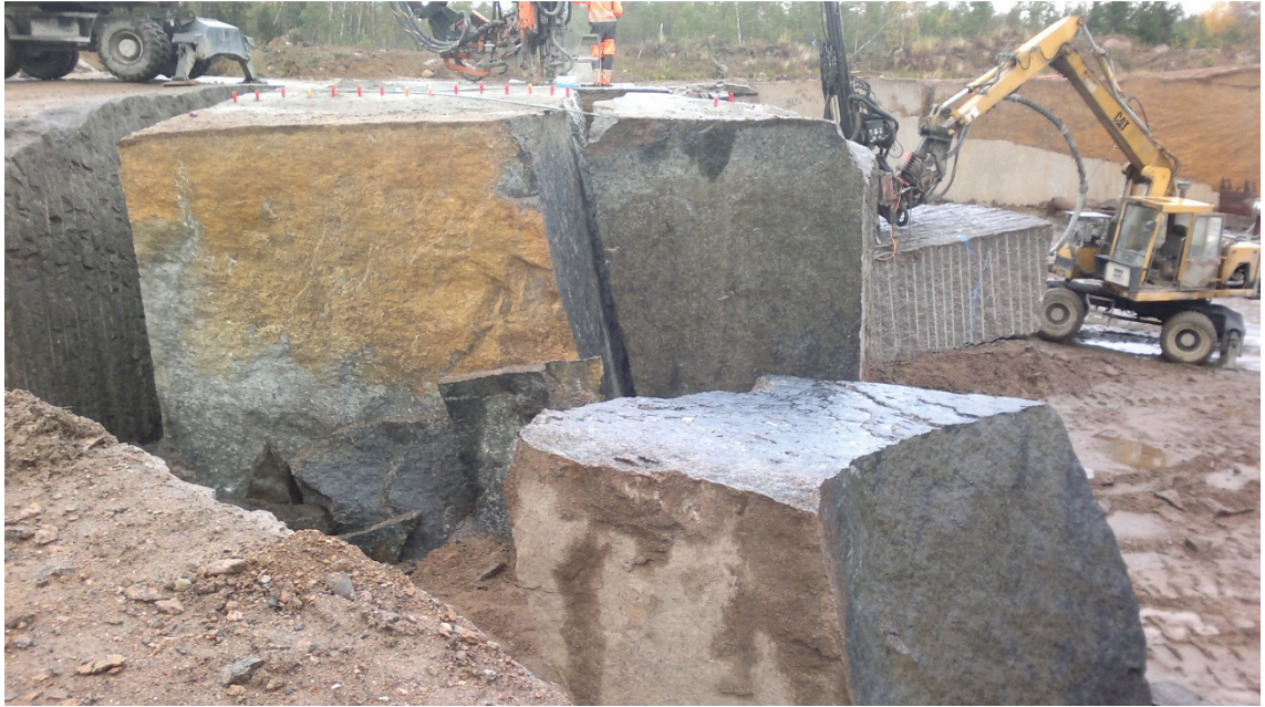
Kuva 12. Väliltä 8,5 -13,8 m sivukiveksi meneviä osia. Etualalla on nurkasta kaadettu lohkare, jossa on tummien mineraalien peittämät rakopinnot, ja lohkare on värivirheellinen. Pitkittäisraon oikea puoli ja vasen puoli menevät sivukiveksi pinnalla näkyviin porausreikiin saakka, koska tässä osassa on kaksi vinosti kamin poikki menevää rakolinjaa, joista toinen oli musta nauha ja kivi on lisäksi värivirheellistä.
