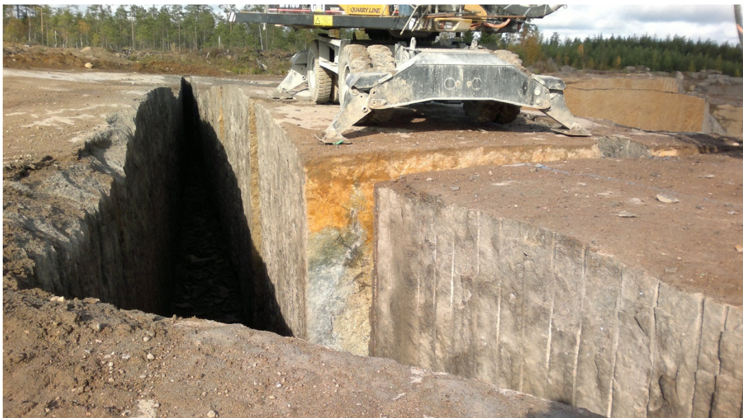
Kuva 6. Kamin takaseinä irrotuksen jälkeen kamin alkupäästä (0 m/8 m) katsottuna. Takanurkan koordinaatit ovat (3,7 m/8 m) koska alkupää porattiin vinoksi irtoamisen helpottamiseksi. Koneen edessä näkyvä rakopinta kamin poikki on 8,5 m kohdalla.
