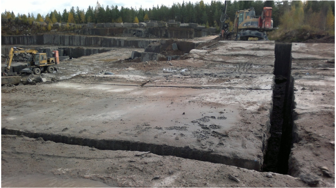
Kuva 7. Näkymä kamin takanurkasta (45 m/8 m) kamin irrotusräjäytyksen jälkeen.
