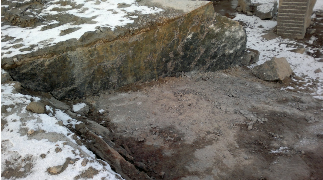
Kuva 23. Edellisen kuvan etureunan lohkeama (sijainti pituus paalulla 36,5 m).
