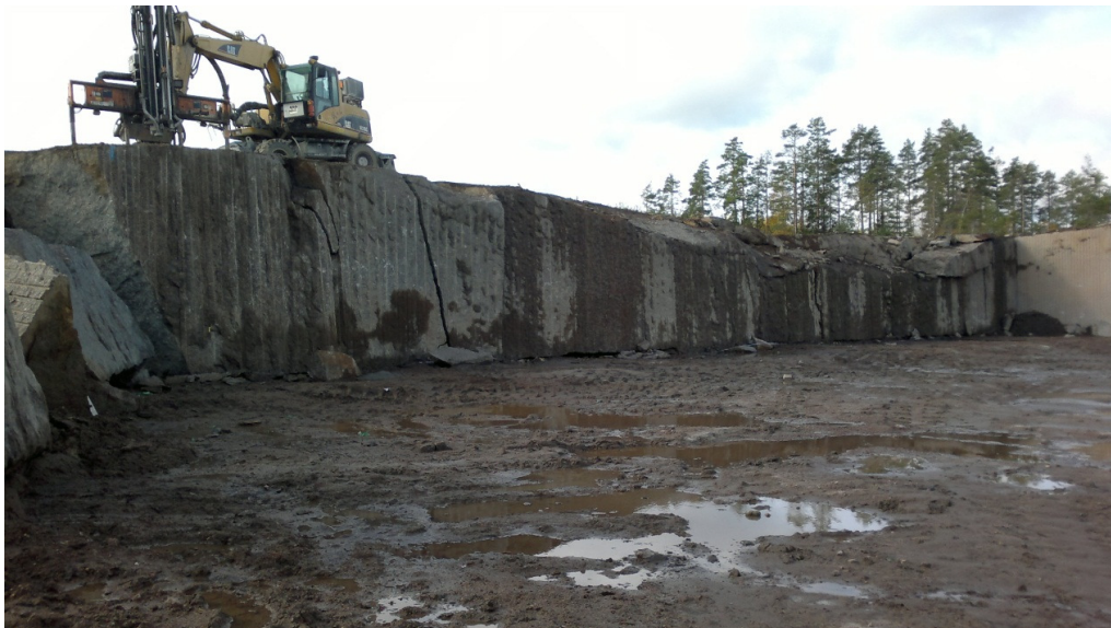
Kuva 2. Kamin etuseinä irrotusräjätysten jälkeen.
