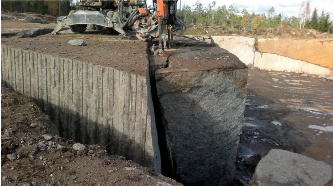
Kuva 5. Kamin pääty irrotuksen jälkeen, kaatolohkareen poraus on käynnissä. Porattavan kaatolohkareen paksuus on 1.9m, joten kamin pituussuuntainen rako on kallion pinnalla noin 2.5 m päässä kamin etuseinästä. Pituussuuntaisten rakojen kaateet olivat 70-75 astetta kamin etuseinää (linja 0) kohti.
