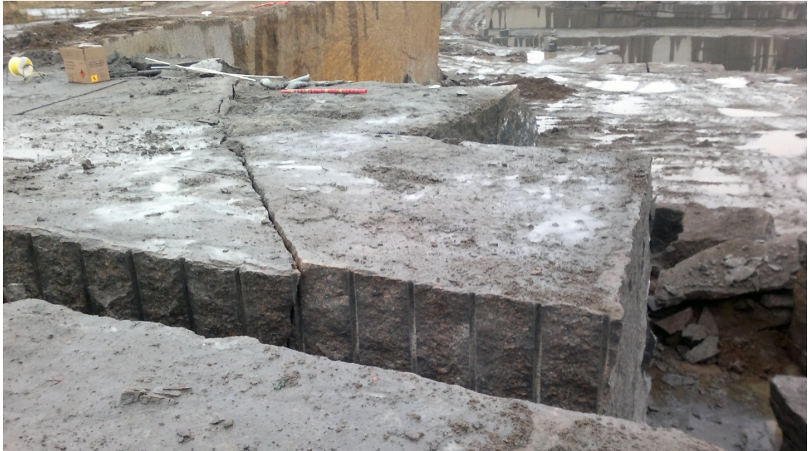
Kuva 25. Kamin loppupään raot kallion pinnalla. Räjähdeaatikon luona poikittainen rako 41,5 m kohdassa, vinosti leikkaava rako etualalla ja pitkittäinen rako nurkan lohkeaman kohdalla. Louhittu pääty on kohdassa 35 m.
