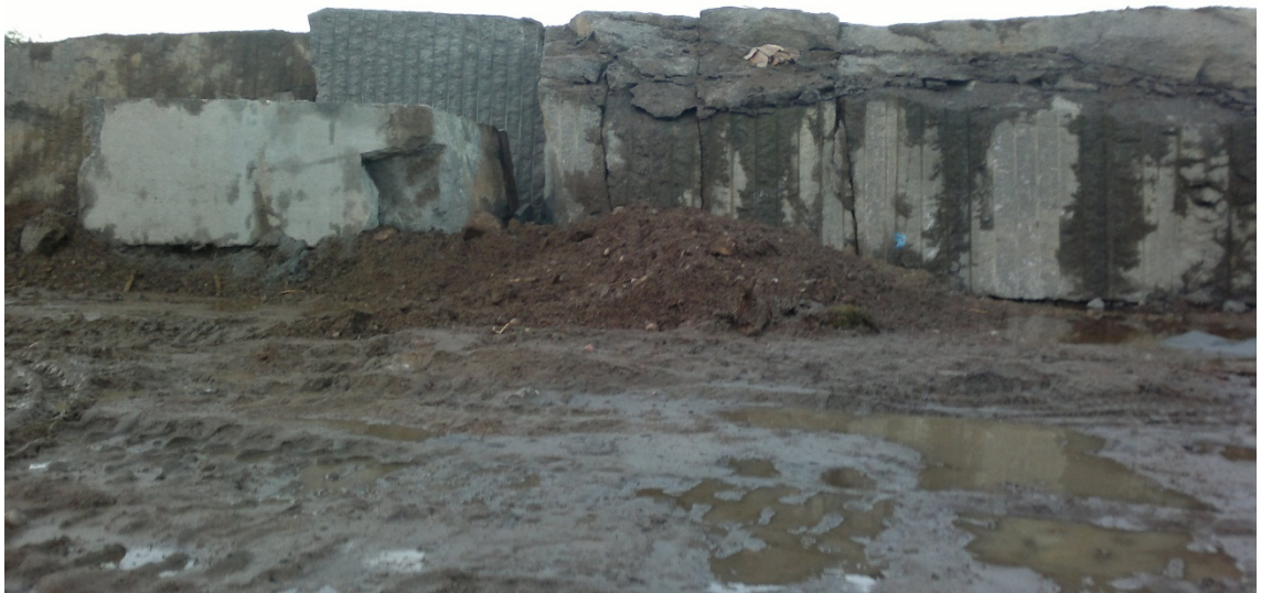
Kuva 17. Kaatolohkare väliltä 19,5 m-24,2 m ja linjojen 3,2-5,1 m väliltä. Kallion pintaosa katsojaan päin kaadettuna. Näkyvissä räjäytysvian päättyminen kaatolohkareen keskivaiheilla. Nurkassa räjäytysvika päättyy pystyyn rakopintaan, joten loppupään pitkittäisrako linjalla 4,3 m jatkuu pinnassa hiukan pidemmälle kuin kamin irrotuksen jälkeen näytti.
