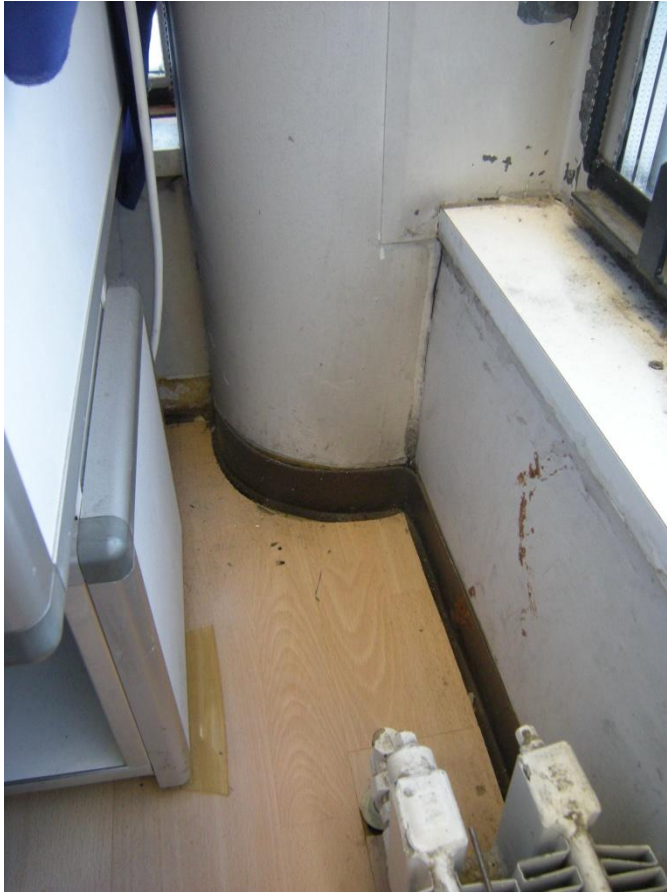
KUVIO 14. Liikehuoneiston nurkka, josta lämpökamerakuva otettu.
