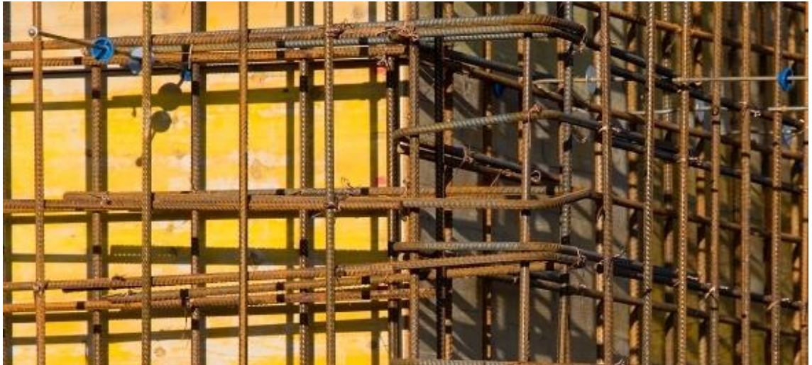
Kuva 2. Paikallavalettavan seinän raudoitus.
