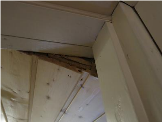
Kuva 10. Yläpohjan rakenteet avoimina sisäilmaan
