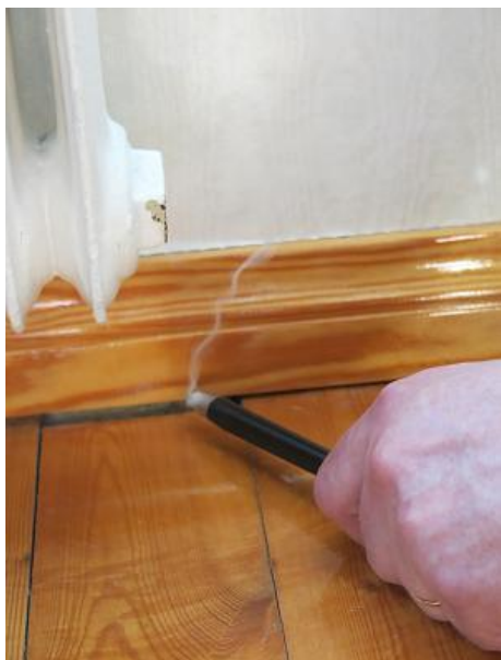
Kuva 20. Ilmavuoto talon eteläseinustalla idän puoleisessa olohuoneessa
