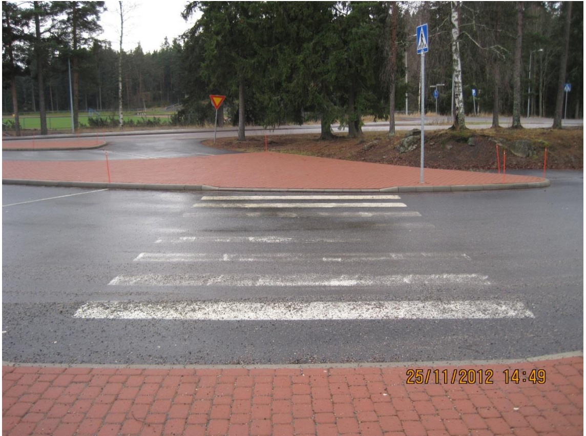
Kuva 13. Koulukeskuksen bussilaiturit ovat korotettuja ja näin ollen helposti havaittavissa. Maalauksen uusimista tulee harkita.
