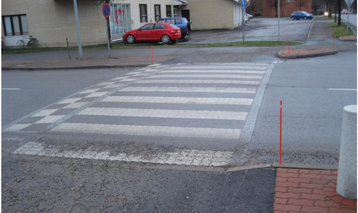
Kuva 4. Hyvättyläntien ja Karjatien risteykseen rakennettu korotettu suojatie on selkeästi merkitty ja helppokulkuinen.
