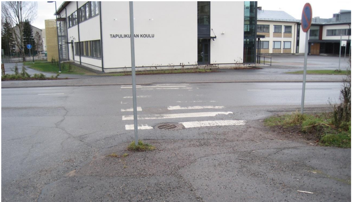
Kuva 3. Karjatien ja Keskustien risteyksen suojatieltä on heikko näkymä ajoradalle. Lisäksi pinnan epätasaisuus ja huonot merkinnät tekevät suojatiestä vaarallisen.
