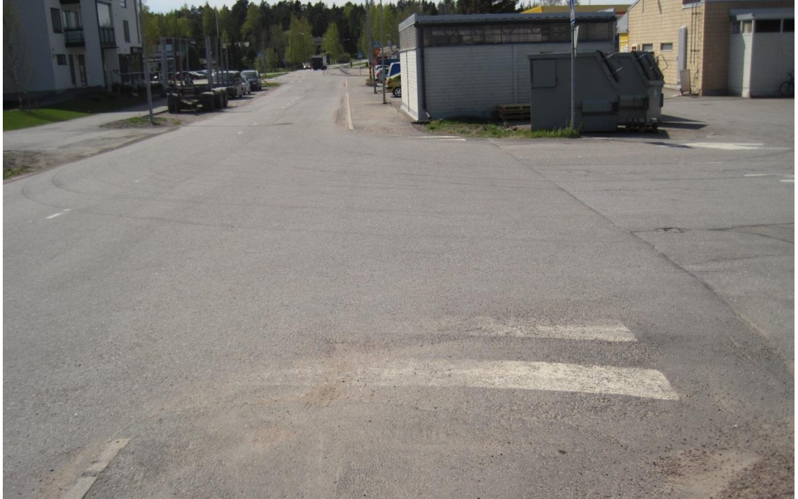
Kuva 12. Lidliin päästäkseen on käytettävä tätä kapeaa kulkuväylää ja huonosti havaittavaa suojatietä.
