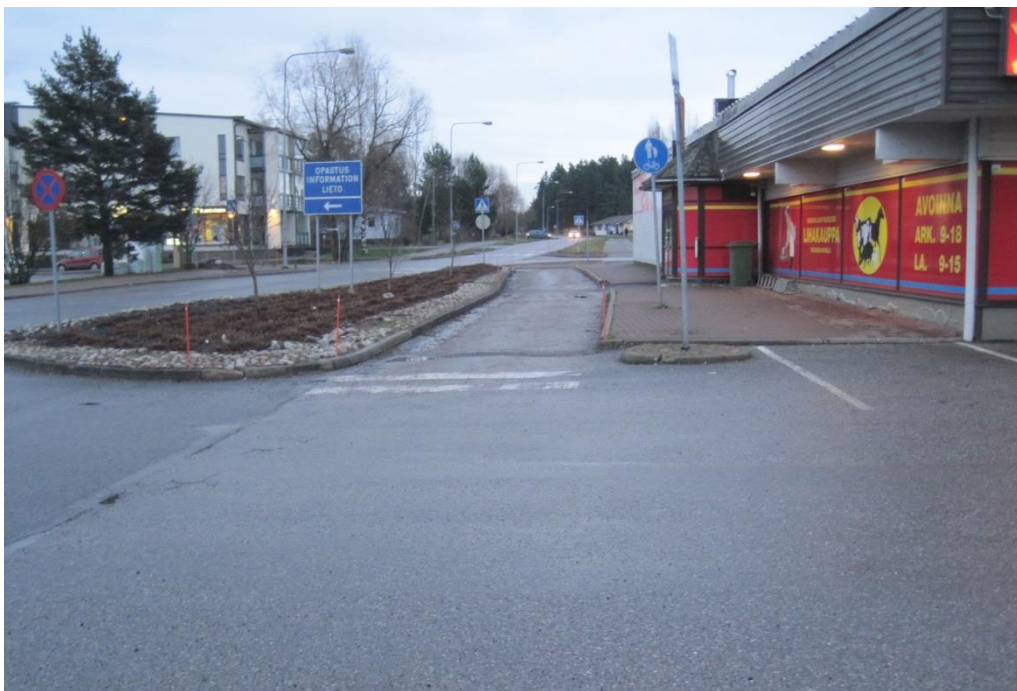
Kuva 11. Kulkuväylä on kapea ja pysäköintialueen ylittävän suojatien maalaus kulunut ja heikosti johdattava.
