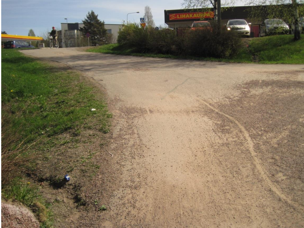
Kuva 10. Valtatien 10 alittavan alikulun pituuskaltevuus on jopa 15 %. Se vaikeuttaa kulkua ja on vaarallinen heikentyneen liikuntakyvyn omaaville. Heikosti hoidettu harjaus tai lumenpoisto tekee liikkumisen mahdottomaksi.
