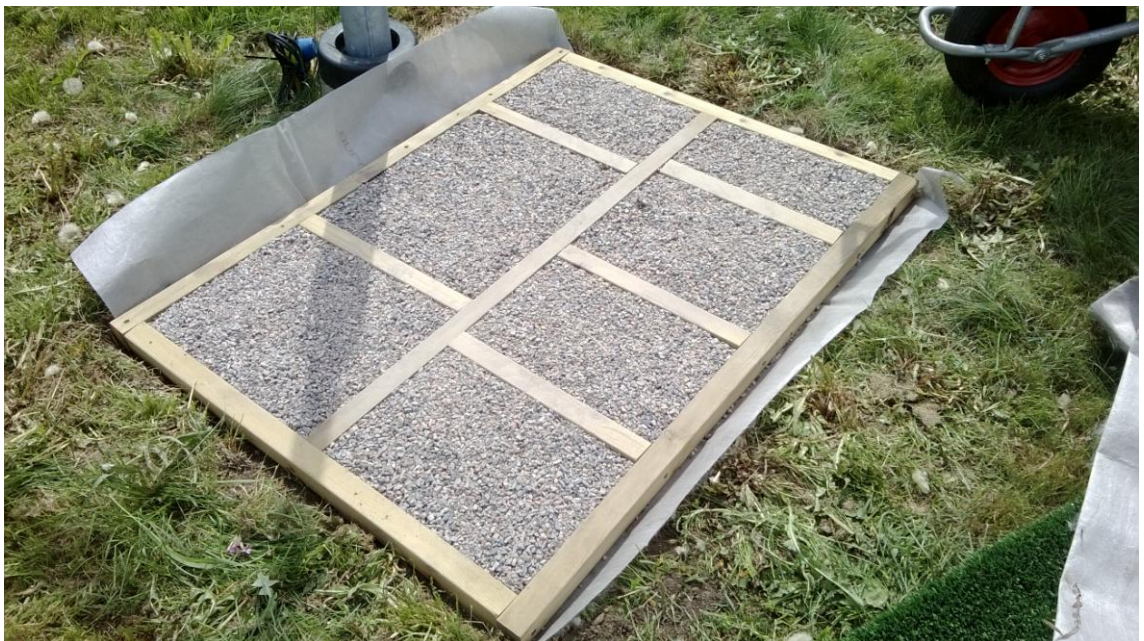
Kuva 4. Keinonurmialustan pohja. Keinonurmen asennusvaiheisiin kuuluivat nurmikon lapiointi, puukehikon valmistus, hiekan asettaminen, kahden juuriestekangaskerroksen asettaminen sekä keinonurmimaton ruuvaaminen.
