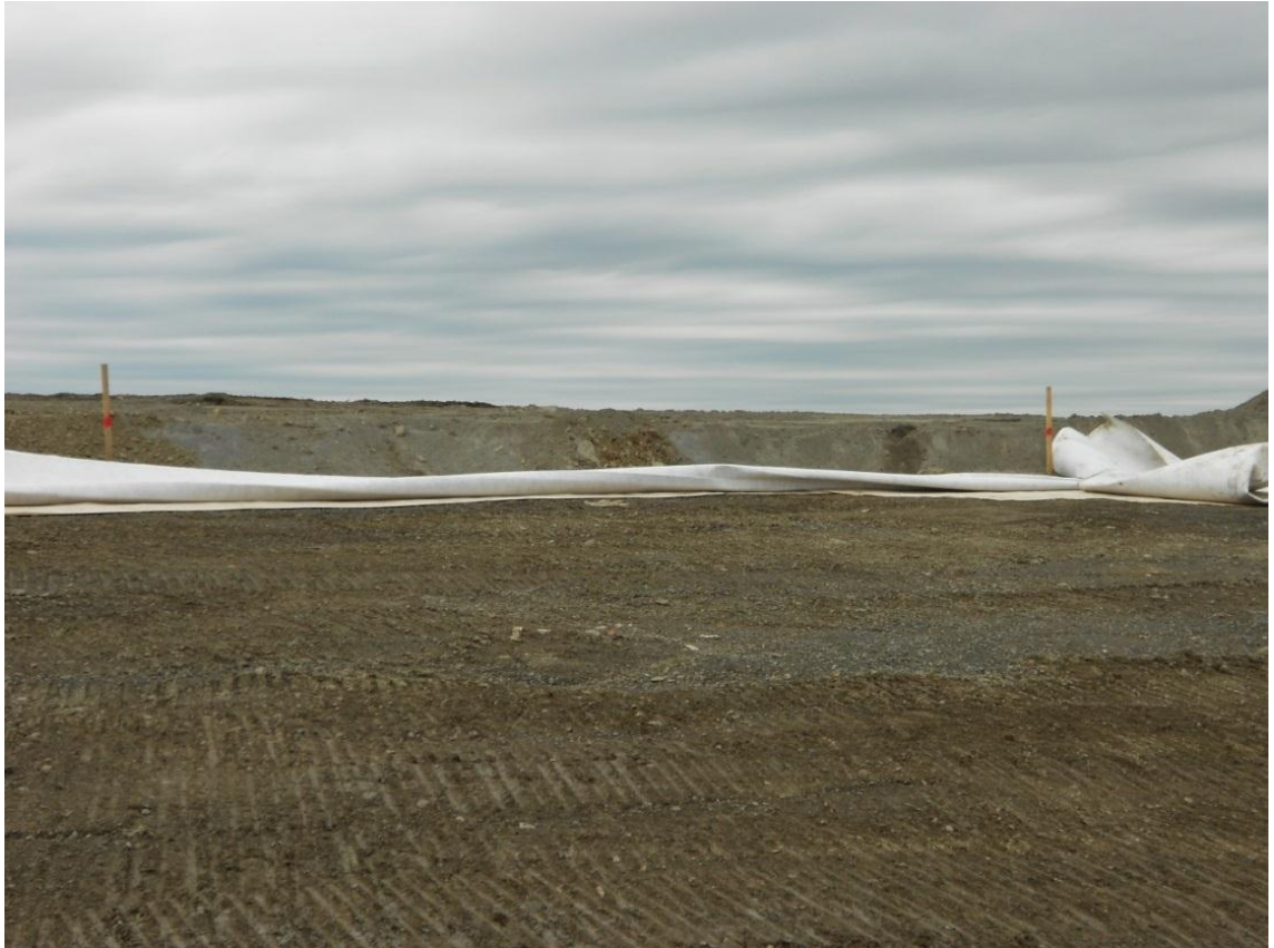
Kuva 23. Salaojamaton päälle levitettyä pintakerrosta.
