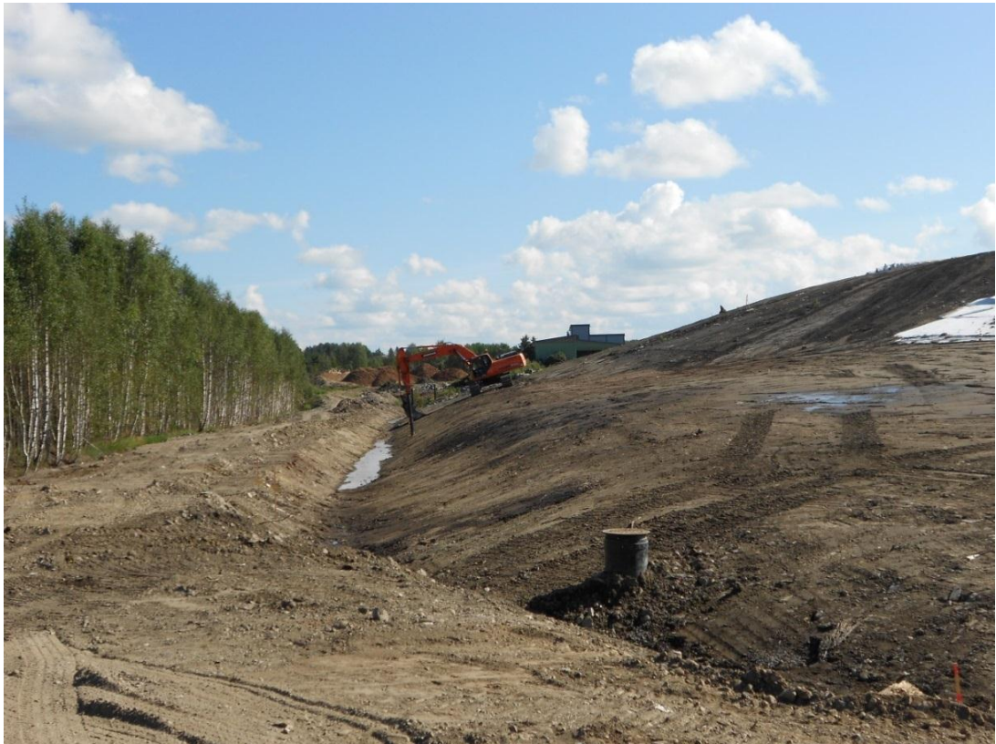
Kuva 13. Avo-ojan rakentamista jätetäytön helmassa.
