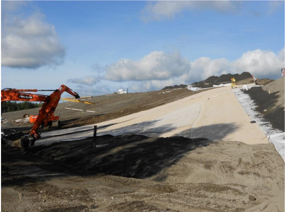
Kuva 22. Luiskan reunaan rakennettua kuivatuskerrosta.
