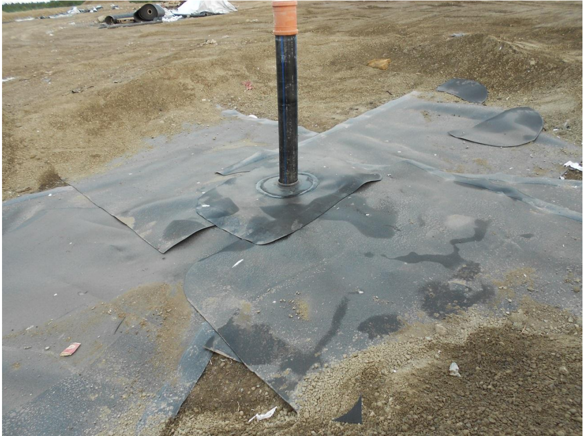
Kuva 17. LLDPE -muovikalvot hitsattuina kaasukaivon ympärille.
