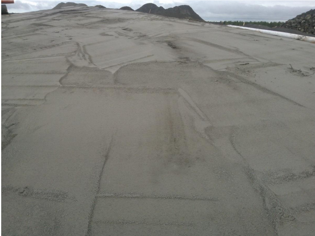
Kuva 11. Valmista esipeittokerrosta ja bentoniittimaton asennuspintaa.
