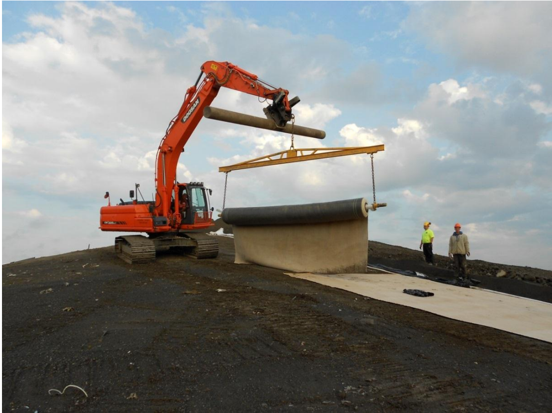
Kuva 19. Bentoniittimaton levityspuomi sekä asennusalustan tasaukseen käytettävä putki.
