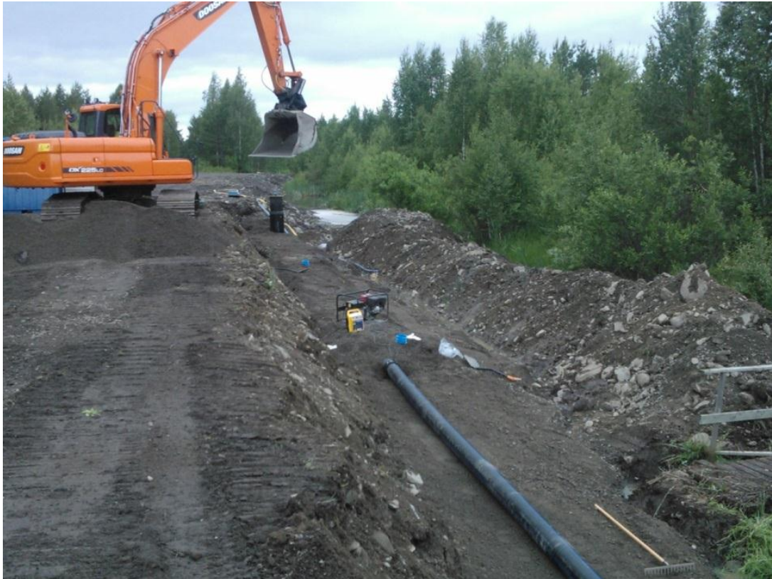
Kuva 12. Viettoviemärin rakentamista salaojien kokoojakaivolta kohti ilmastus- ja selkeytysaltaita.
