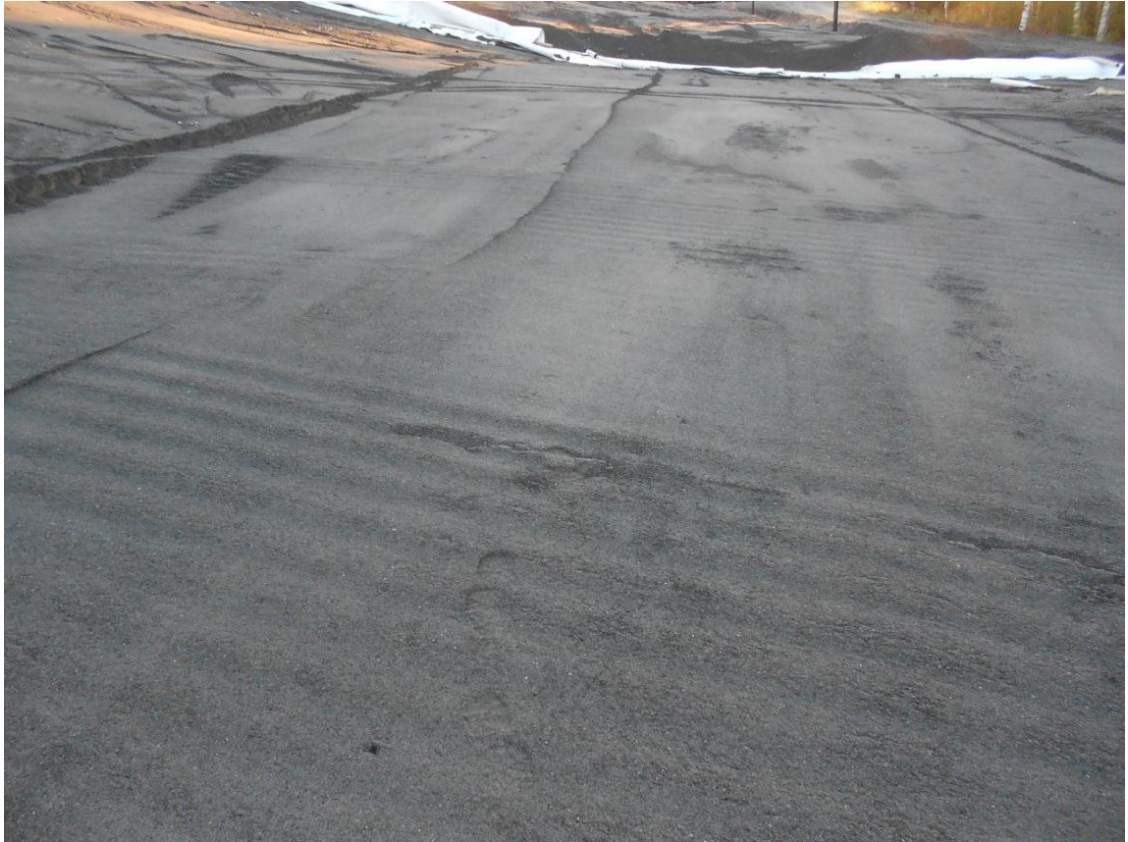
Kuva 18. Bentoniittimaton asennusalustaa.
