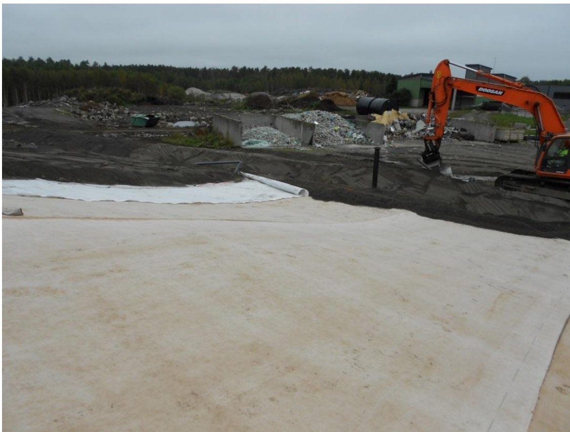
Kuva 20. Asennettua bentoniittimattoa.
