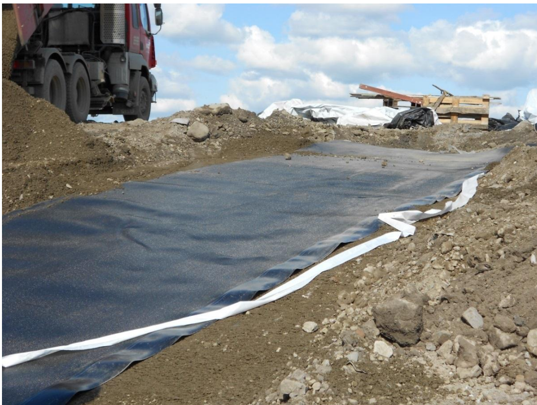
Kuva 16. LLDPE -muovikalvoa asennettuna.
