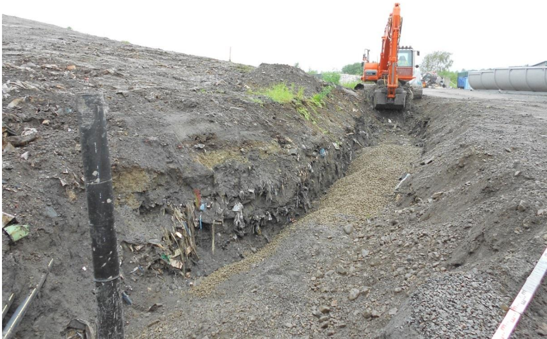
Kuva 14. Suotovesisalaojalinjan rakentamista.
