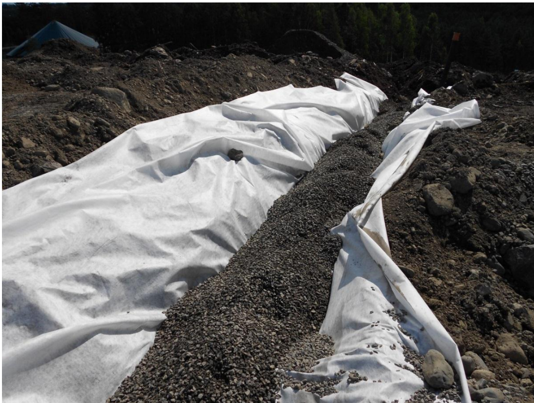
Kuva 15. Kaasusalaojalinjan rakentamista.
