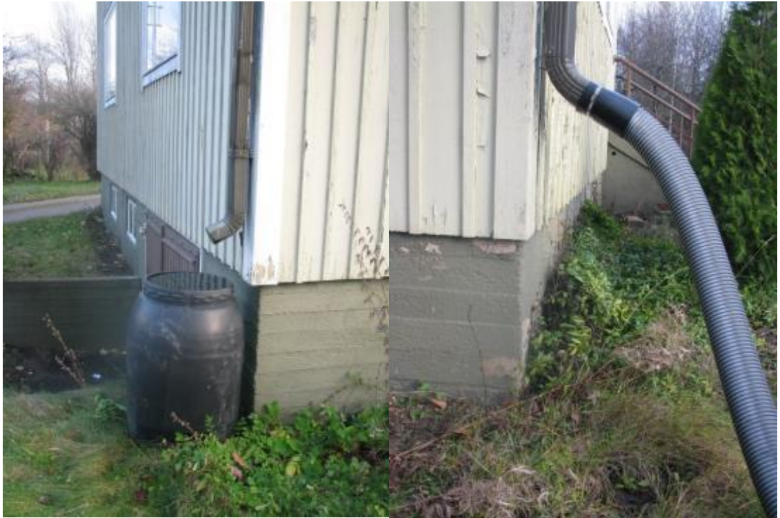
Kuva 4. Osa sadevesistä on ohjattu kauemmas rakennuksesta
