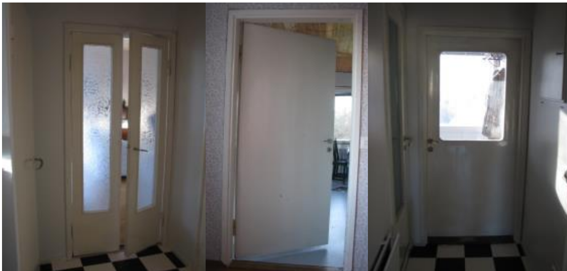
Kuva 18. Rakennuksessa on paljon vanhoja väliovia.
