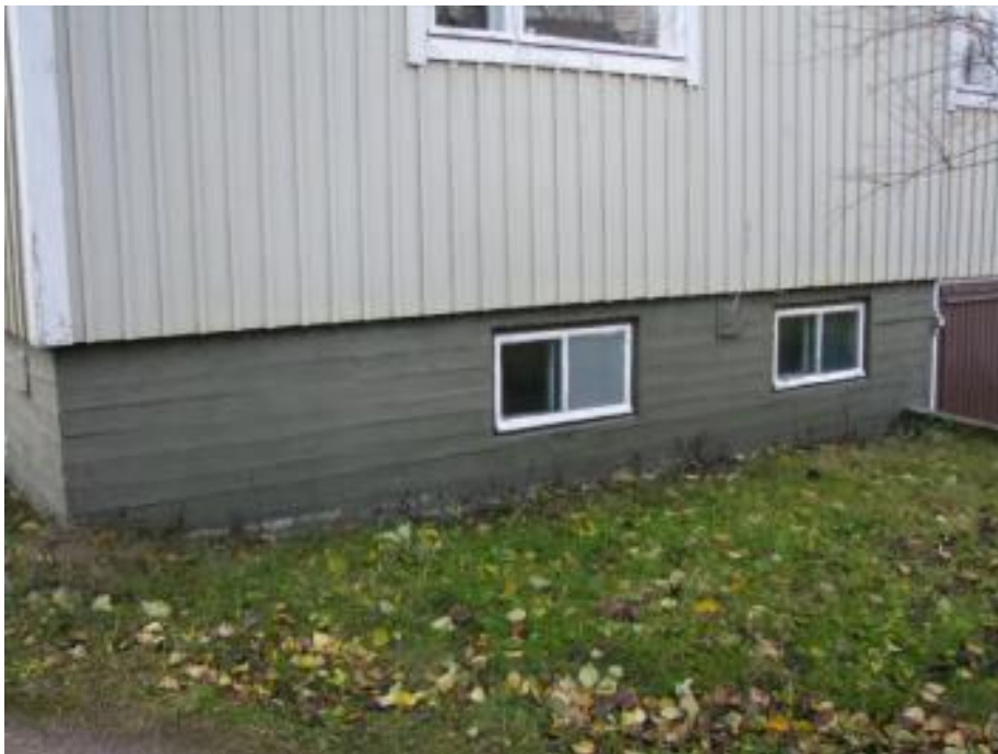
Kuvat 5. Perusmuuria ulkopuolelta
