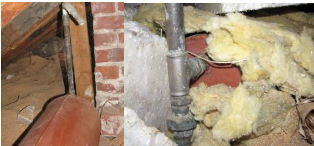
Kuva 25. Vanha paisuntasäiliö ja sen putket poistetaan.
