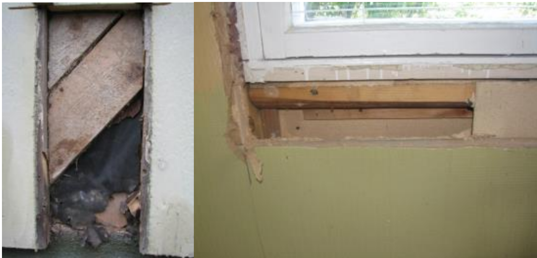
Kuva 7. Avattua seinää ulko- ja sisäpuolelta
