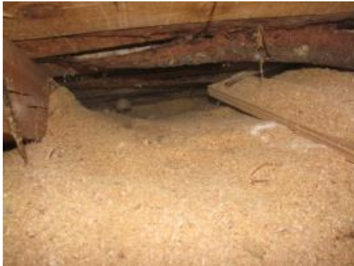
Kuva 12. Yläpohjan purueriste on kuivaa.
