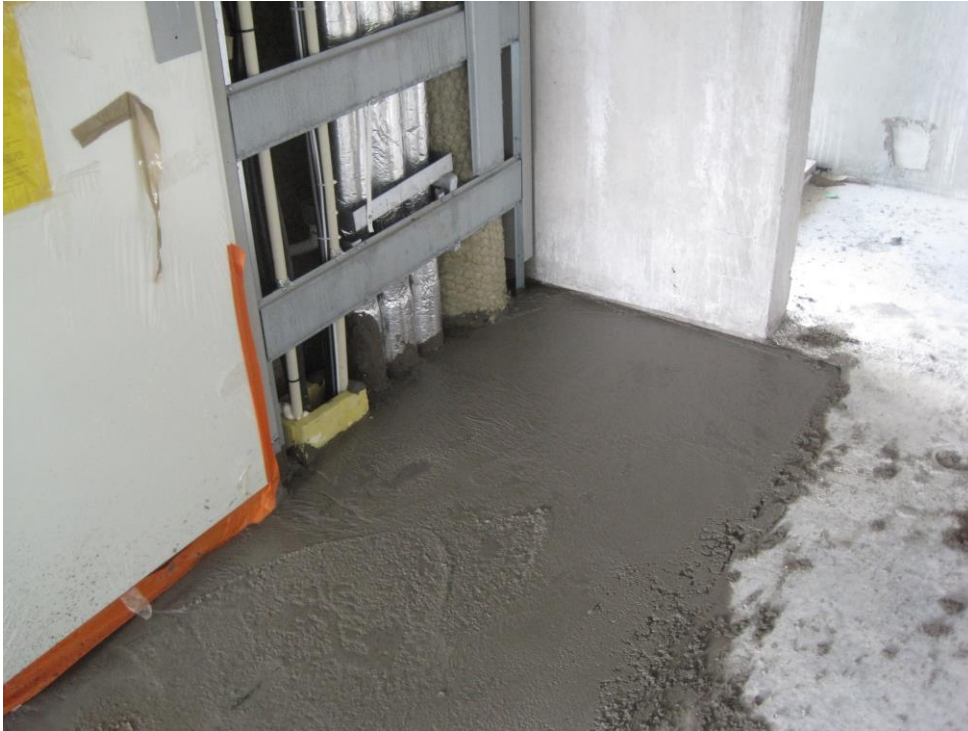
KUVA 3. Nousukuilun palokatko ja kylpyhuone-elementin reuna valettuna
