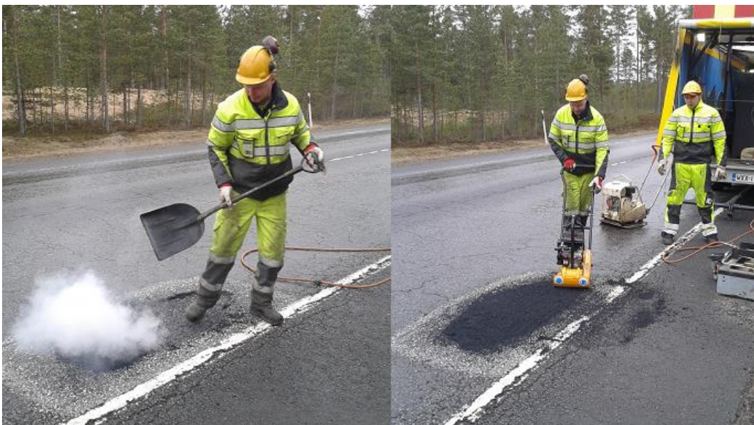
KUVA 11. AB-paikkausmassan levitys ja tiivistys
