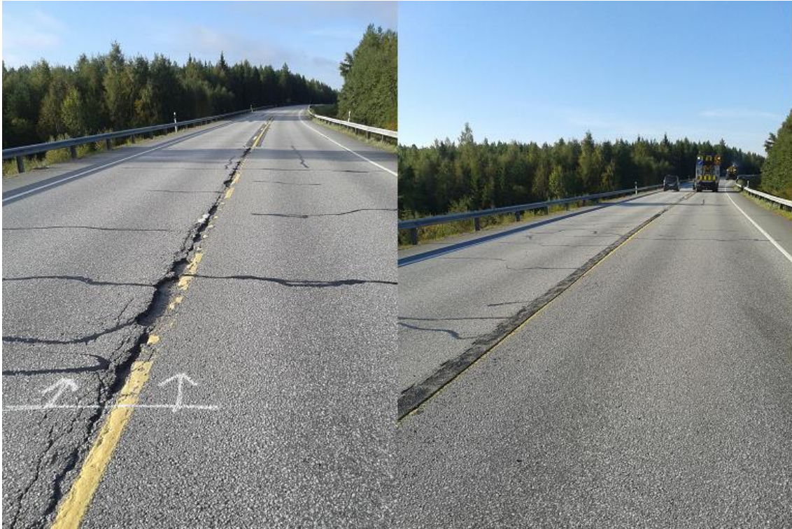
KUVA 14. 20 cm leveä KT-valuasfalttipaikka
