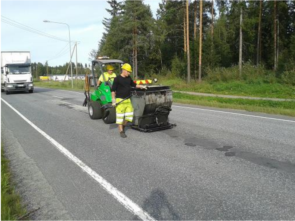
KUVA 15. KT-valuasfalttipaikan levitys
