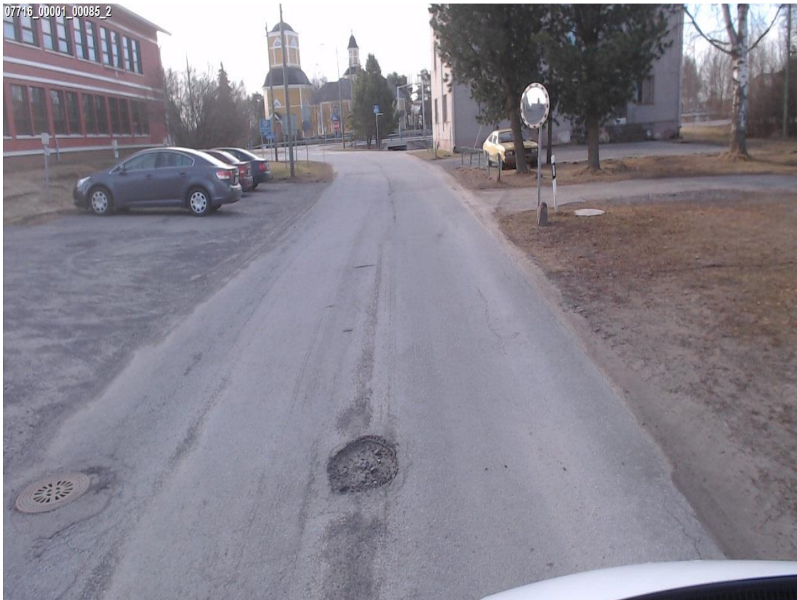
KUVA 3. Keskellä tietä oleva reikä
