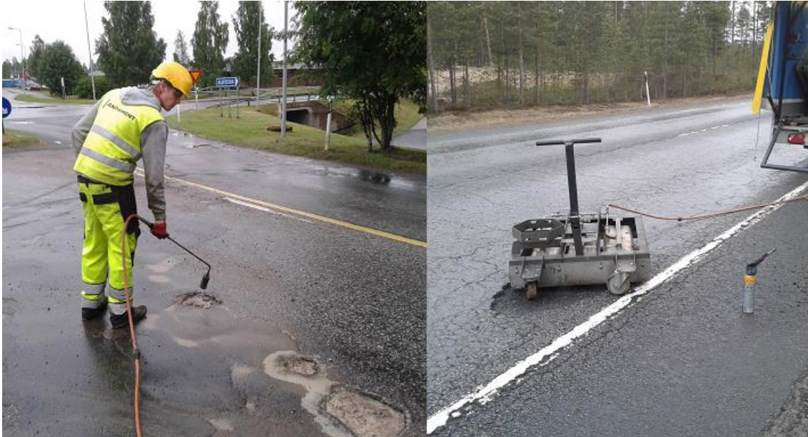
KUVA 10. AB-paikkauksen yhteydessä tehtävää alustan kuivatusta ja kuumennusta
