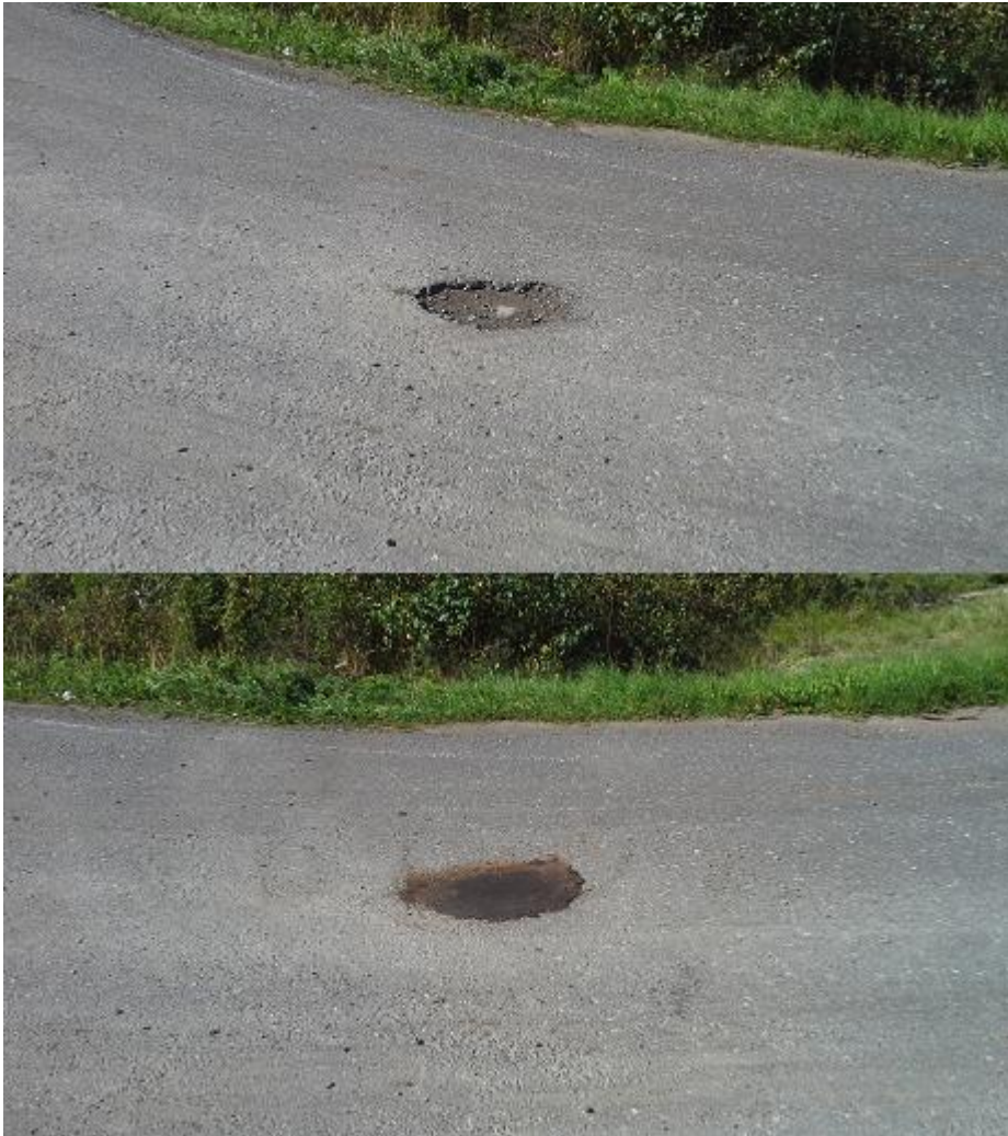
KUVA 8. PAB -kylmäpaikkaus vähäliikenteisellä tiellä
