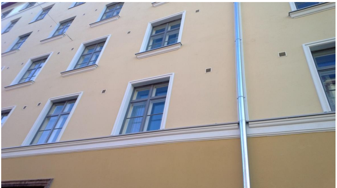
Kuva 20. As Oy Penkan alempi vaakajakolista sekä ikkunapenkit korjattiin paikkarappaamalla. Ikkunoiden kehyslistat sekä ylempi vaakajakolista uusittiin kokonaan Sto Decoprofil -listalla.
