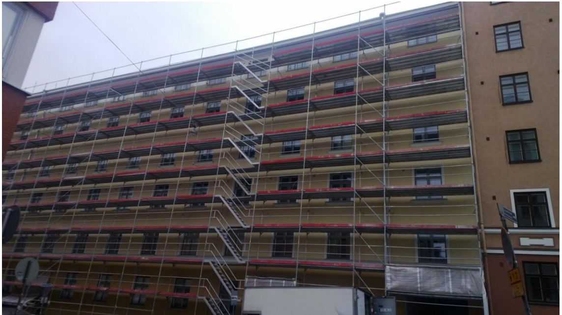
Kuva 6. Teline työn toinen puoli on telineen purku. Tässä telineen peitteet on jo poistettu.
