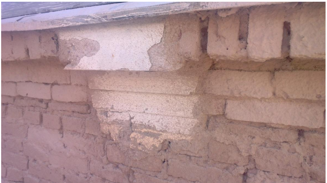
Kuva 13. Alkuperäistä räystääprofiilia on jätetty malliksi. Räystäälle on muotoiltu runko tiilestä muuraamalla.
