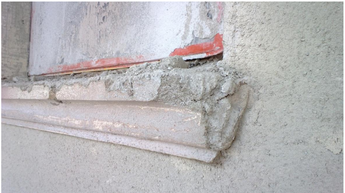
Kuva 17. Jos rappauskoristeet ovat pääosin hyvässä kunnossa, voidaan niitä korjata laastilla paikkaamalla. Tässä tapauksessa ikkunapenkki paikkakorjattiin, koska vanha rappaus oli säilynyt vesipellin alla terveenä.
