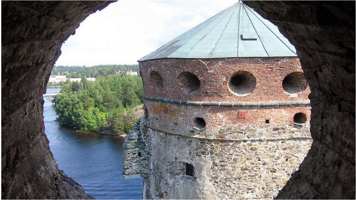
Kuva 1. Olavinlinnan tornin pinnassa on jäljellä vanhaa kalkkirappausta. Alun perin linna on todennäköisesti ollut kauttaaltaan rapattu. Kuva: YLE/Esko Keränen.
