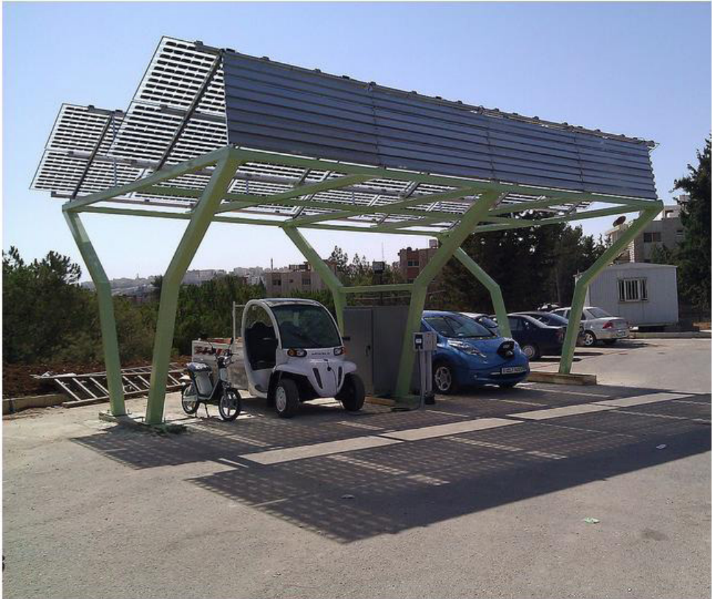
Kuva 5. DBT:n latausasema Jordaniassa.
