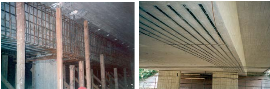
Kuva 126 Lisäraudoitteilla ja hiilikuidulla tehtyjä vahvennuksia /30/
