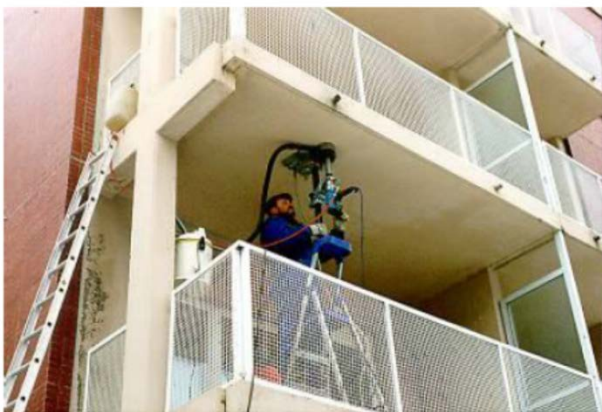
Kuva 135 Parvekkeen alapinnan hiekkapuhallus /15/
