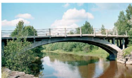
Kuva 75 Tönnön silta Orimattila
