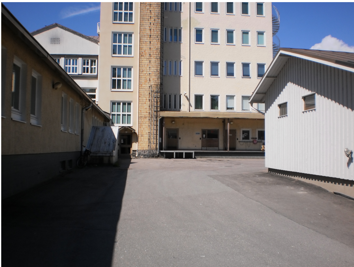
Fig. nr. 4: Området kring ingången. Från vänster till höger: kosthålllet, trapphuset, femvåningsbyggnaden med ingången t.v. och lastningsbryggan t.h., samt garaget.
