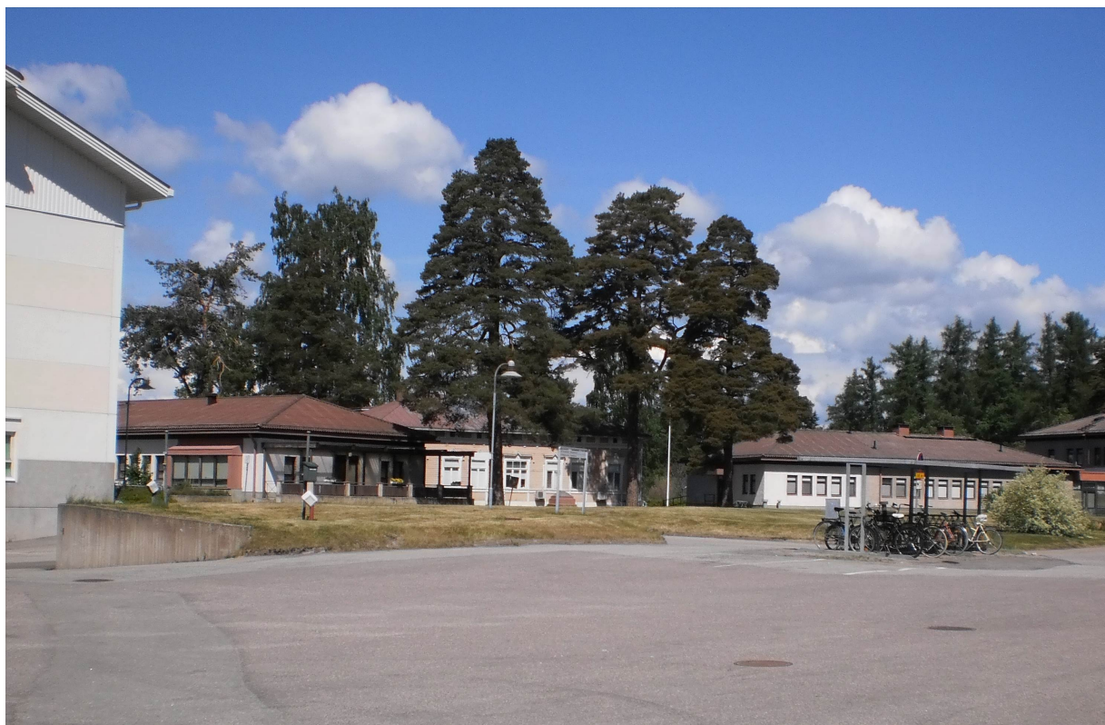
Fig. nr. 6: Gräsområdet t.v. på bilden, var också en del av betongmuren syns, cykelstället t.h.
