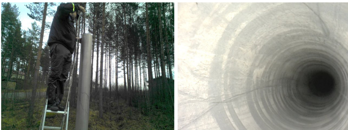
Kuvio 14. Sisääntuloilma putken alkupää.
