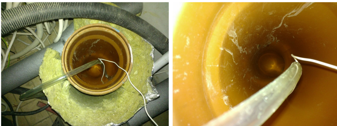
Kuvio 18. Talon sisältä putken loppupäästä.
