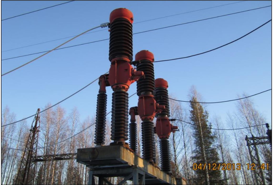
Kuva 6. 110 kV vähäöljykatkaisija
