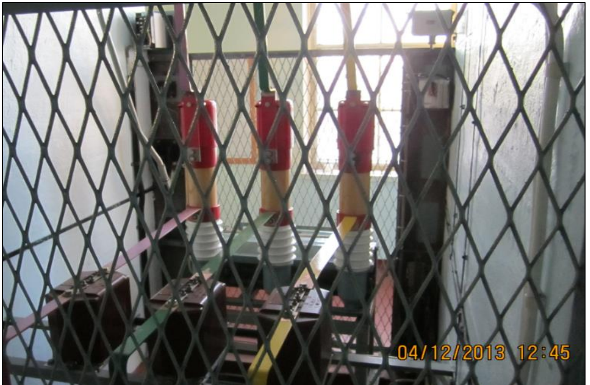
Kuva 7. 20 kV vähäöljykatkaisija
