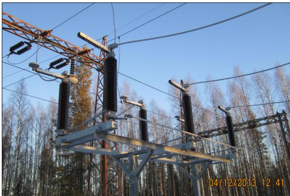
Kuva 9. 110 kV erottimet
