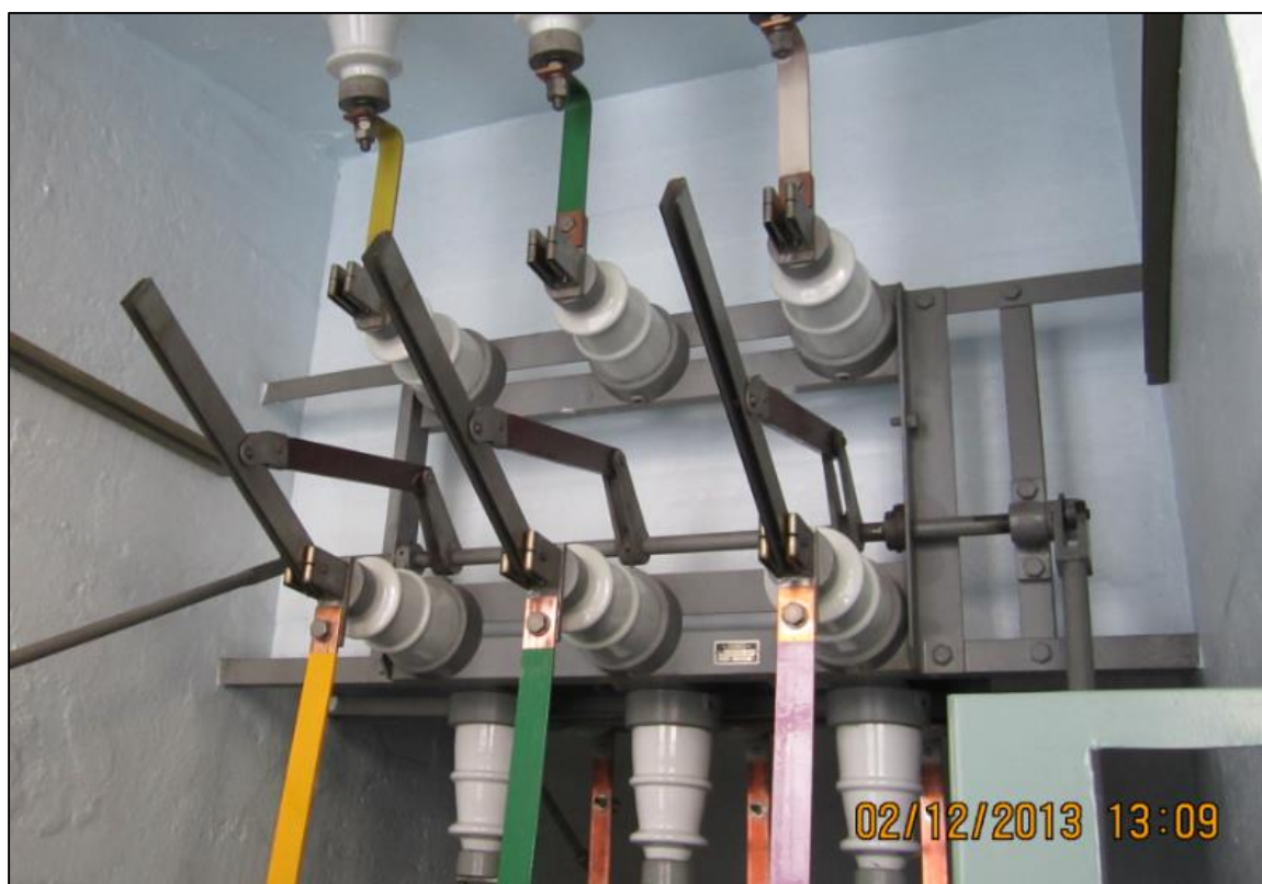
Kuva 10. 20 kV erottimet
