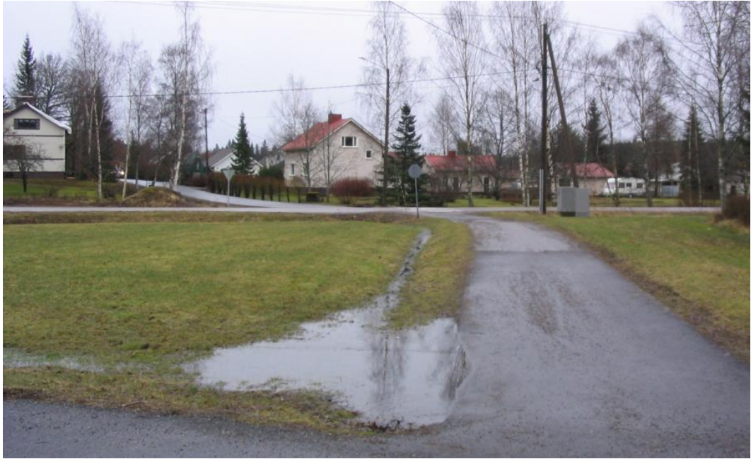
Kuva 11. Lammikoituminen avo-ojassa.
