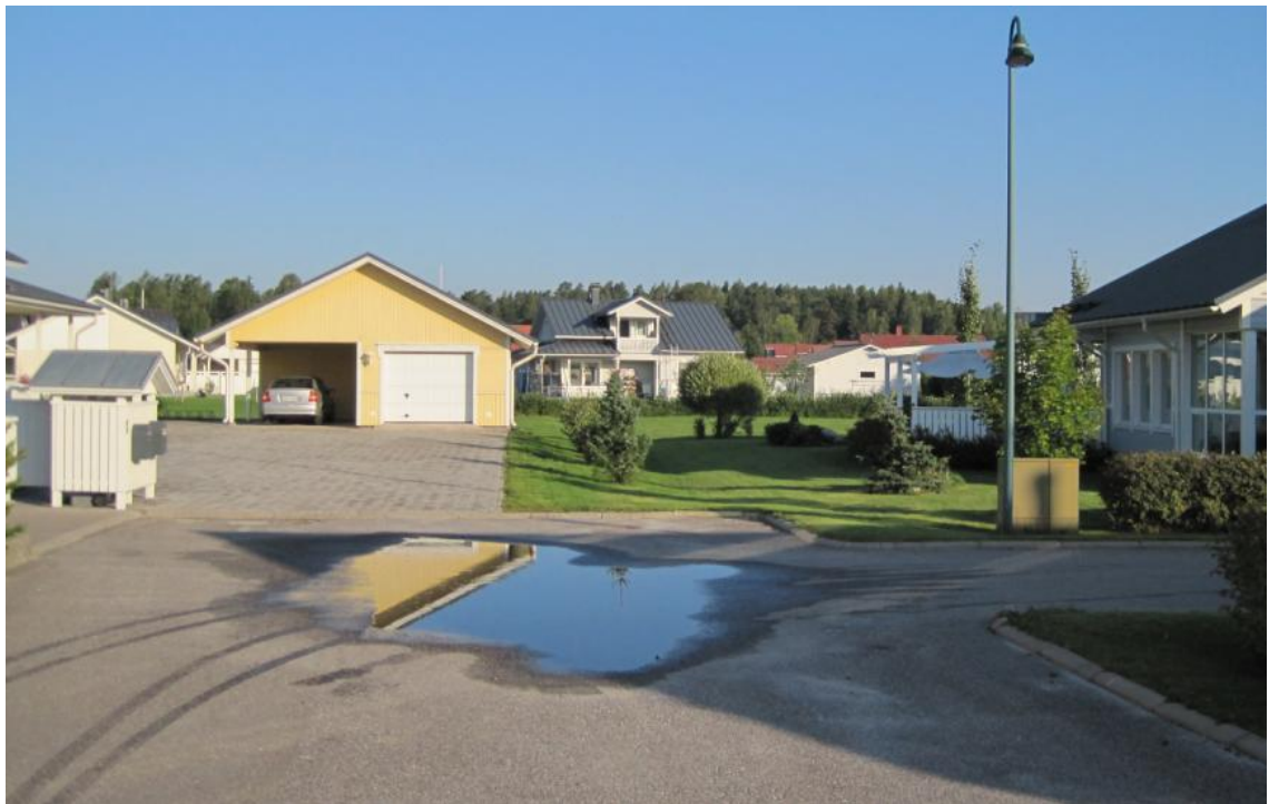
Kuva 9. Lammikoituminen kadulla ilman viemäriä.
