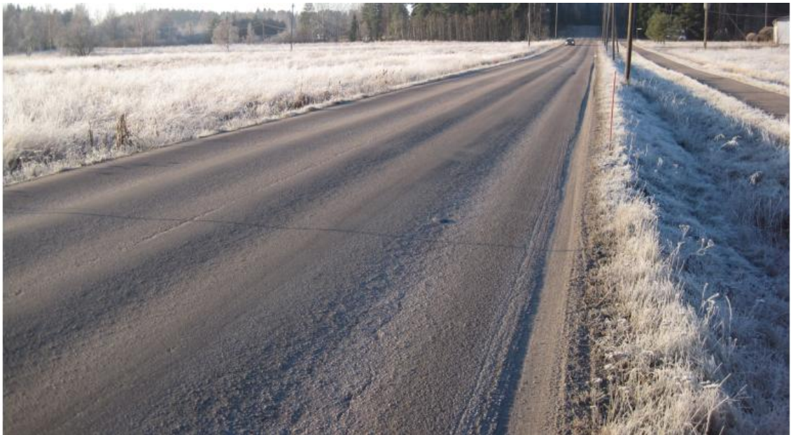
Kuva 19. Urautumista Rakentajantiellä.
