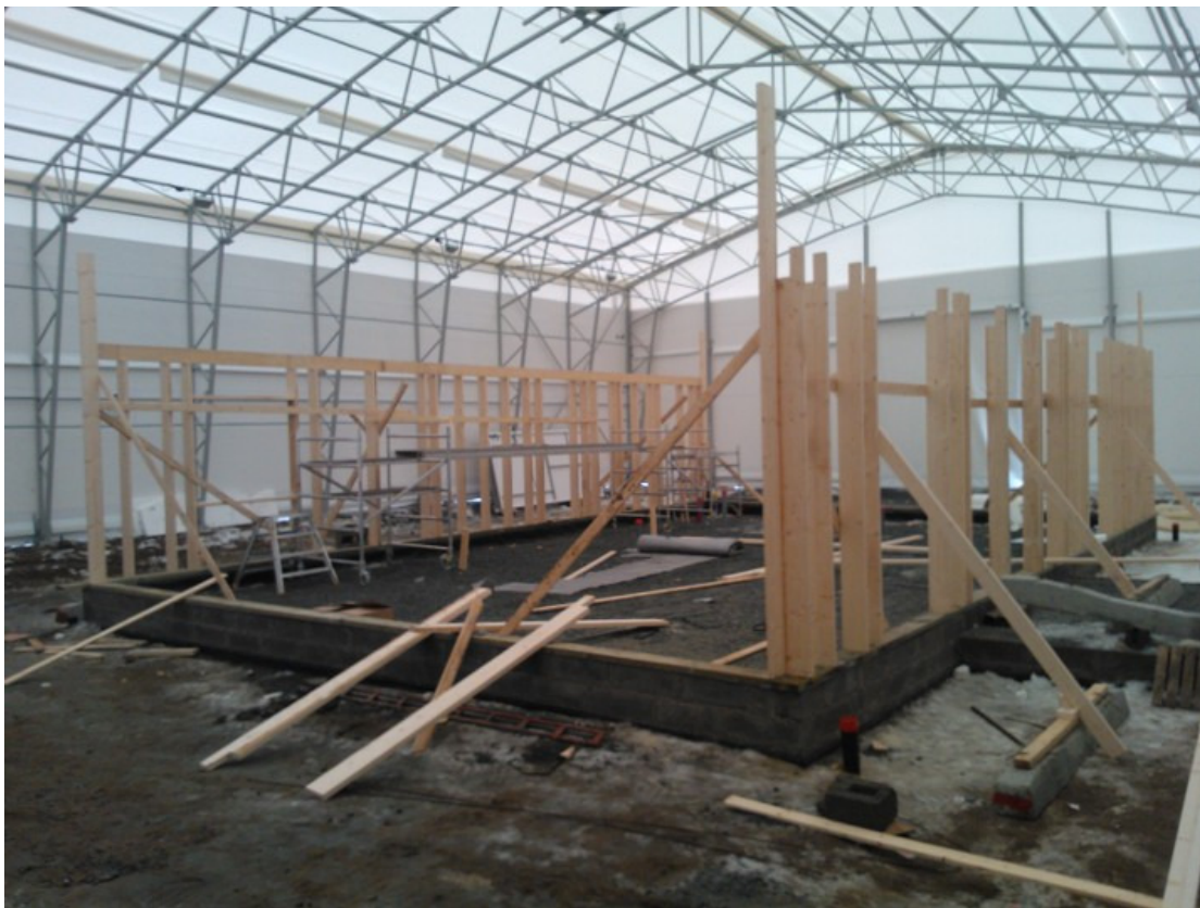
KUVA 2. Talon 1 puurunkotyöt (Vartiainen 2014)
