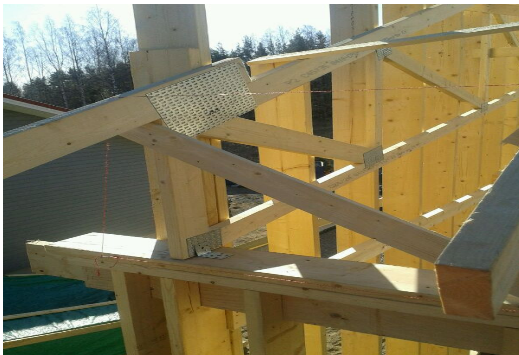
KUVA 9. Linjasuoruuden mittaus (Fomin 2014)
