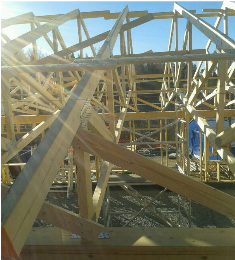
KUVA 4. Talon 3 vesikaton kattotuolit (Puttonen 2014)
