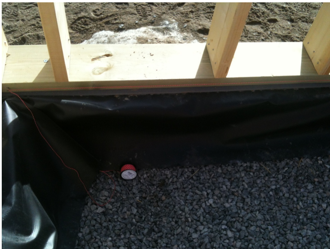
KUVA 6. Seinän suoruuden mittaus. FOMIN 2014
