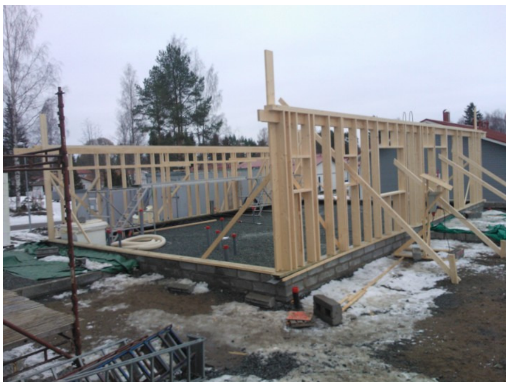
KUVA 3. Talon 3 puurunkotyöt (Vartiainen 2014)
