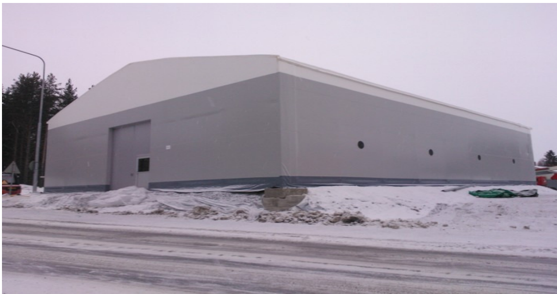
KUVA 5. Talon 1 sääsuojatelta (Vartiainen 2014)
