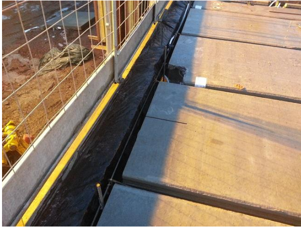
Kuva 17. Ontelolaatat kantavan sandwich-elementin sisäkuoren päällä.
