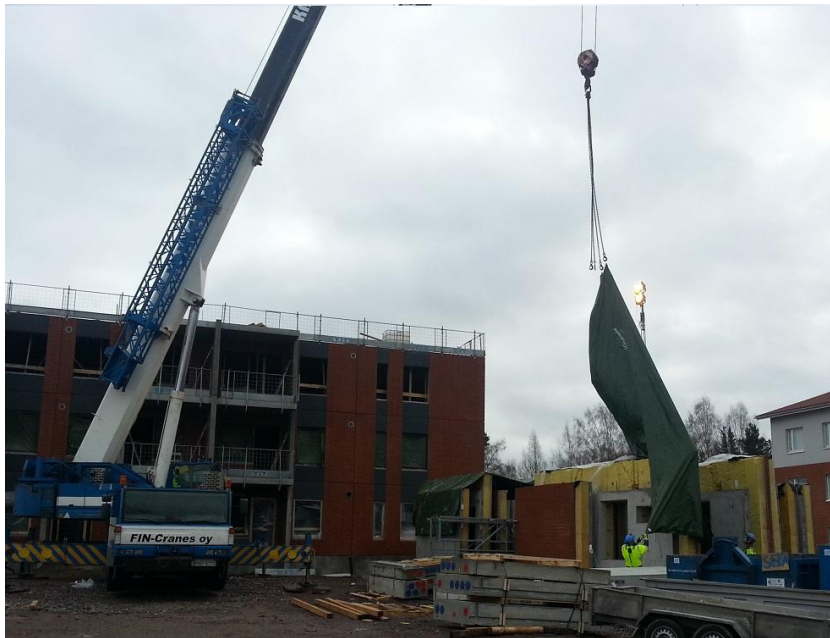
Kuva 15. Lainapeitteiden asennus elementtien suojaksi nosturilla. Taka-alalla jo peitetty elementtiryhmä. Tässä elementtitoimituksessa elementtien suojamuovit olivat pahoin vaurioituneet ja eristeet olivat näin ollen sään armoilla.
