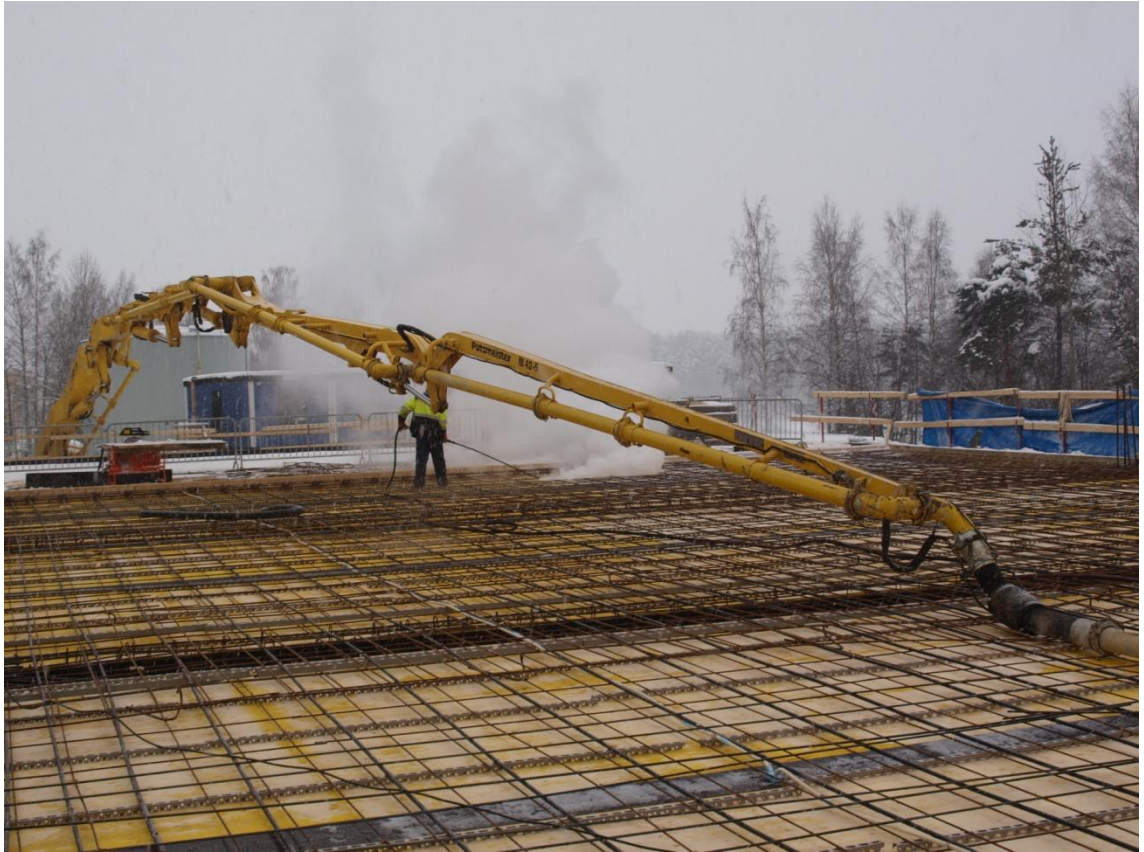
Kuva 8. Lumen ja jään poistaminen muotista höyryttämällä.
