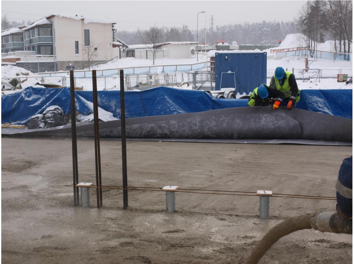
Kuva 11. Pakkasmaton asennus.
