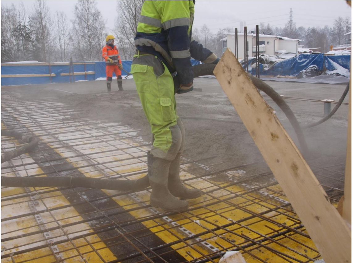
Kuva 10. Betonin valu.
