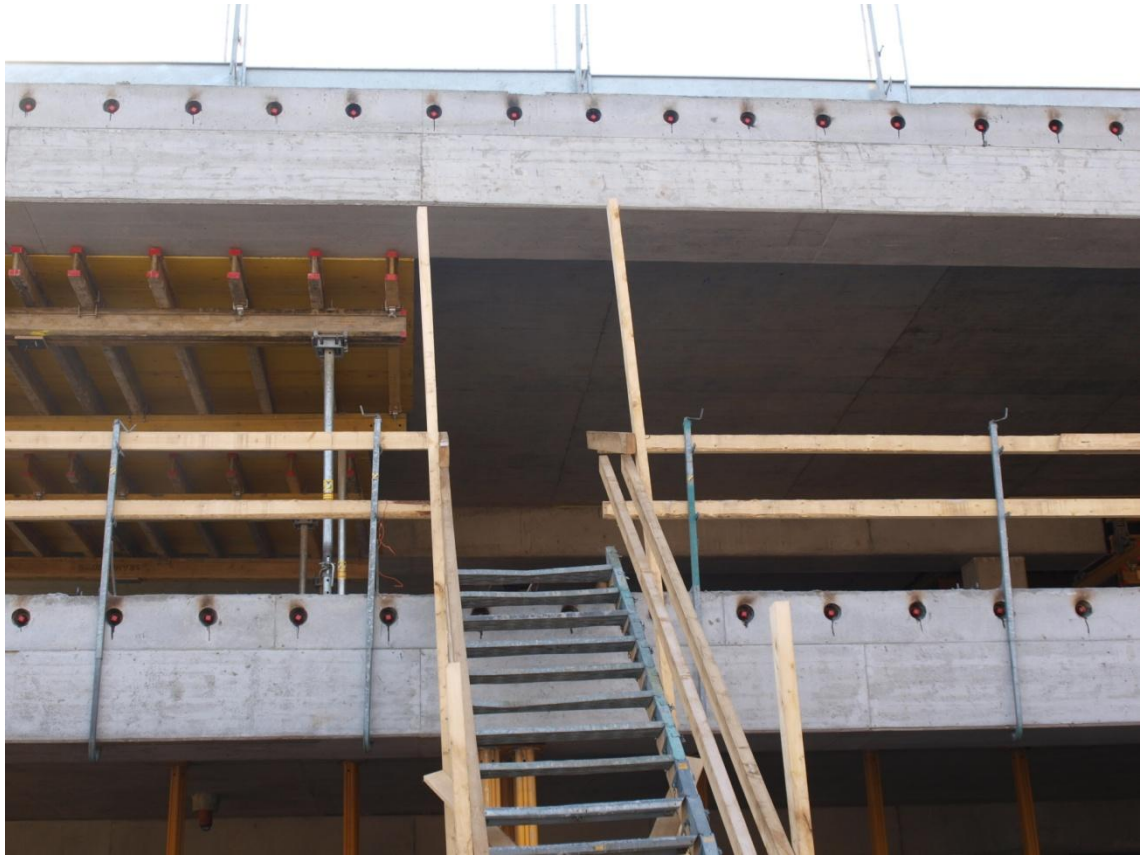
Kuva 14. Jänneterästen katkaistut päät laatussa.
