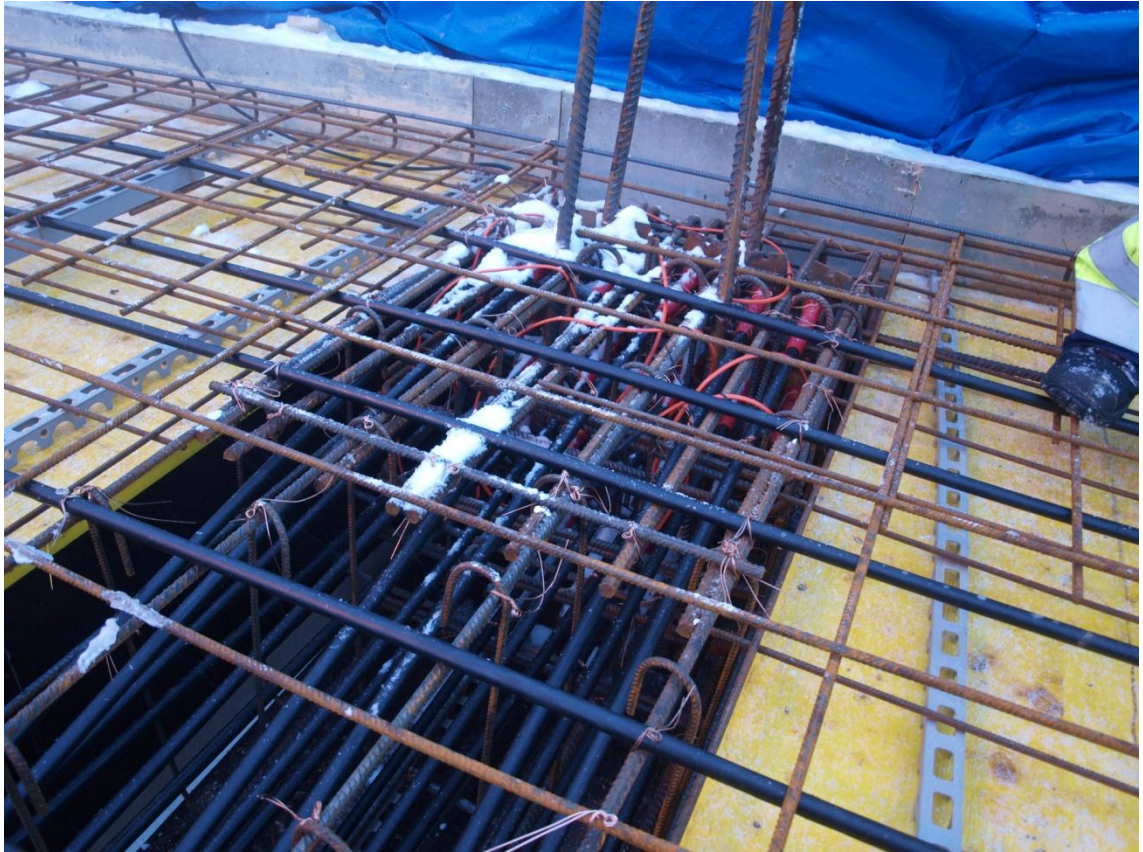
Kuva 3. Lankalämmitys lisätty palkin pätyyn.
