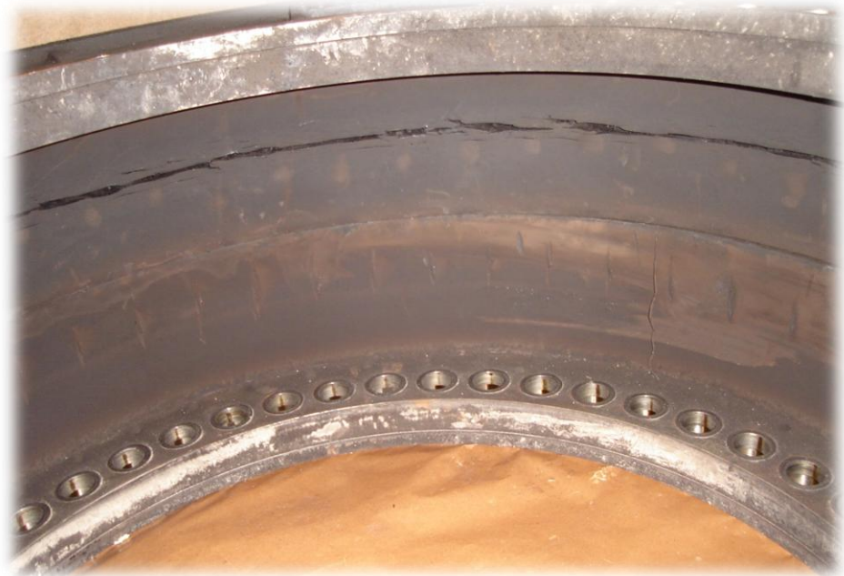
Kuva 40. Halkeama kytkimen sisäkehällä.
