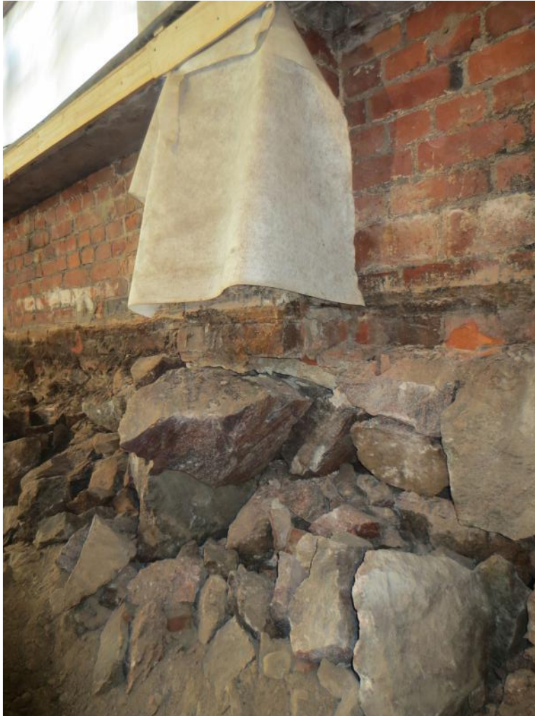
Kuva 12. Perustusten vanhaa kiviladontaa. [11]
