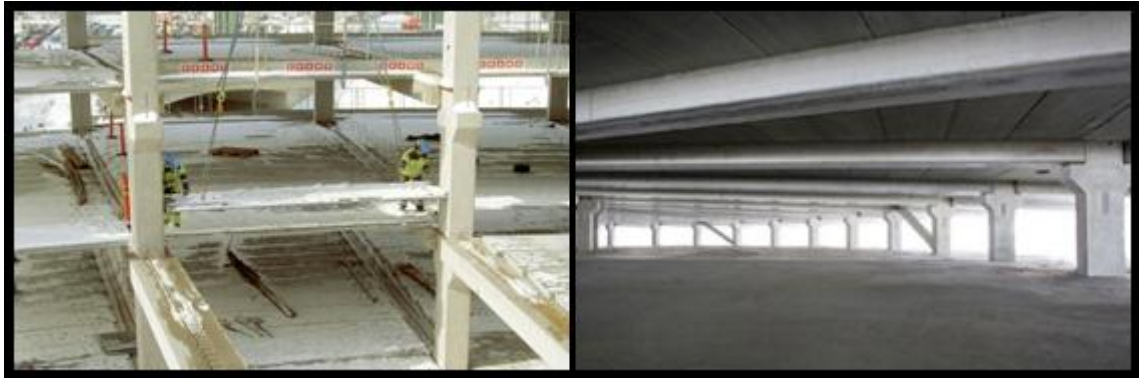
Kuva 4. Helsinki-Vantaa-lentoaseman pysäköintilaitos P3 [6]. Kuvat: Olli Aho, Parma Oy.
