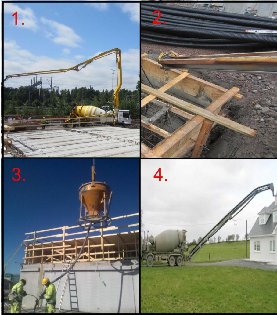
Kuva 19. 1: pumppukalusto, 2: valukouru, 3: nostoastia ja 4: valuhihna. Kuvat: Ville Sikanen (1, 2), Ilmari Lahikainen, NCC Rakennus Oy (3) ja [23] (4).
