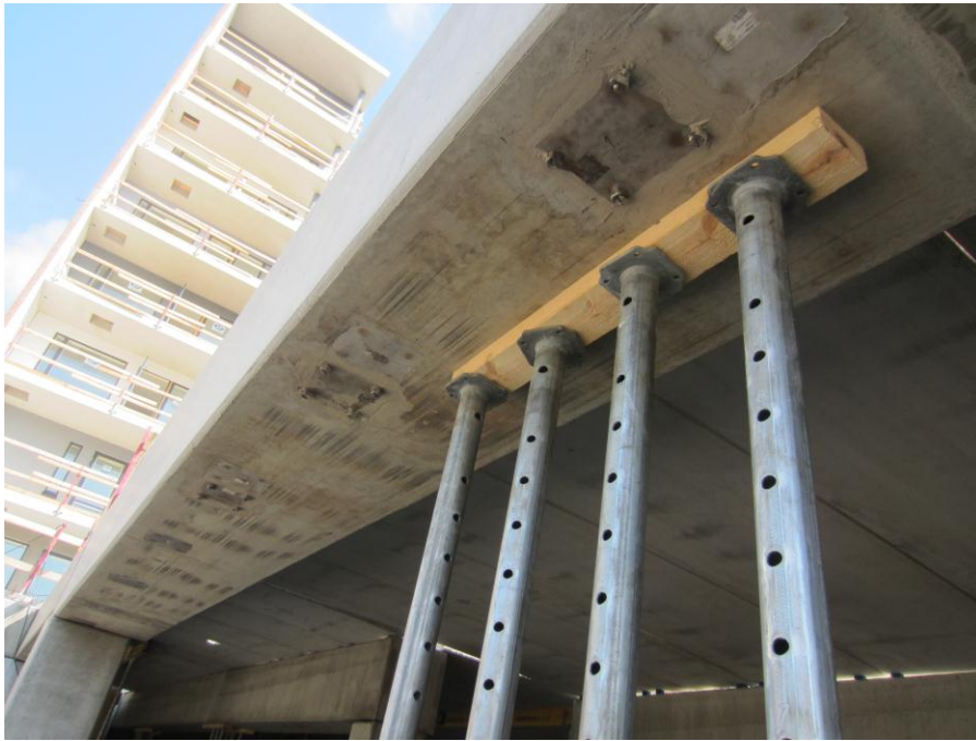
Kuva 34. Kuva palkkien tuennasta asennuksen jälkeen. Kuva: Ville Sikanen.
