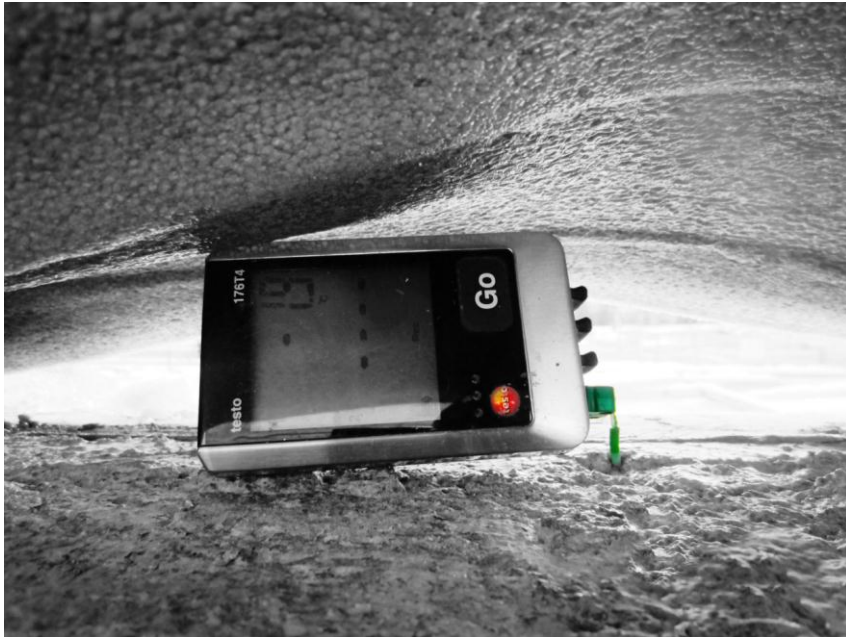
Kuva 20. Väestönsuojaholvin korotusvalun lämpötilaseuranta loppupalvesta. Valu on asianmukaisesti suojattu pakkasmatolla, jotta betonin hydrataatioreaktion tuottama lämpö ei karkaisi ulkoilmaan ja säästyään erilliseltä ulkoiselta lämmitykseltä kevyillä pakkasilla. Kuva ja kuvankäsittely: Jaakko Ylimäki, NCC Rakennus Oy.
