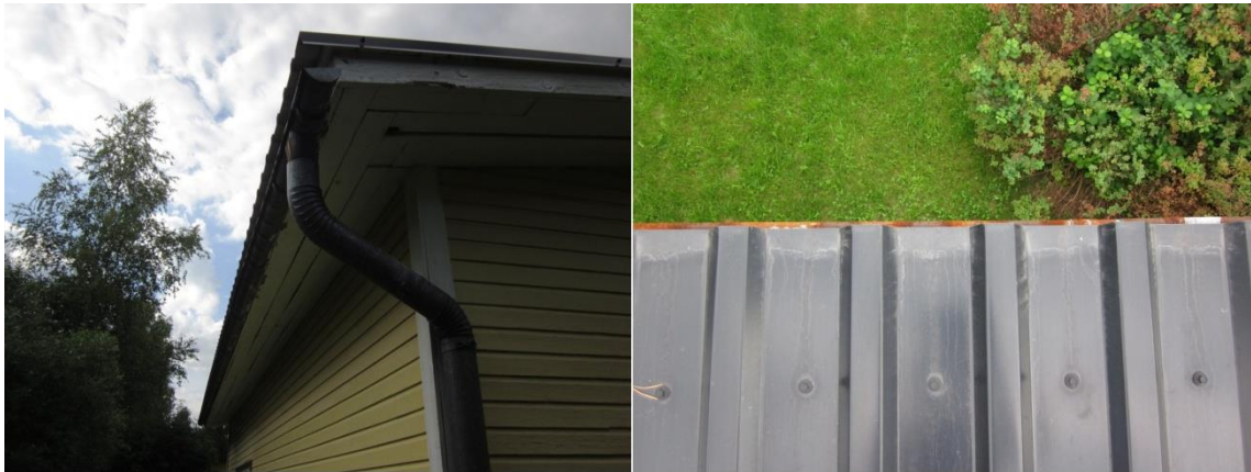
KUVA 4. Vesikourut jäävät liian pitkien peltien alle
