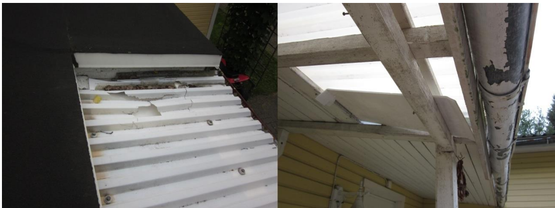
KUVA 5. Reikä valokatteessa. Vauriota on yritetty korjata vedenohjaimella
